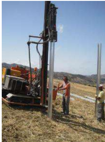
Figura 11. Montaje de estructura soporte
