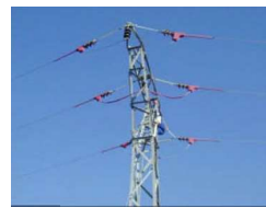
Vista del conductor y grupo aislados 36KV
