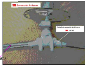
Vista del conductor y grupo aislados 36KV
