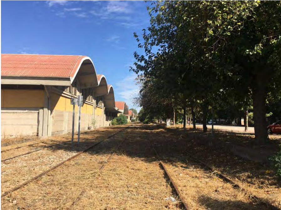
Estado actual de la Avda. del Guadalhorce
