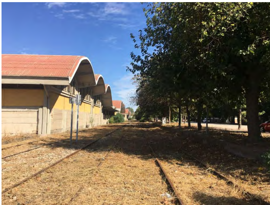
Estado actual de la Avda. del Guadalhorce
