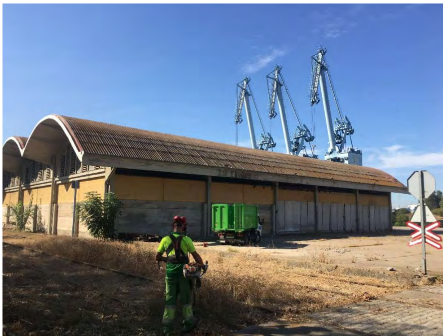
Estado actual de la Avda. del Guadalhorce
