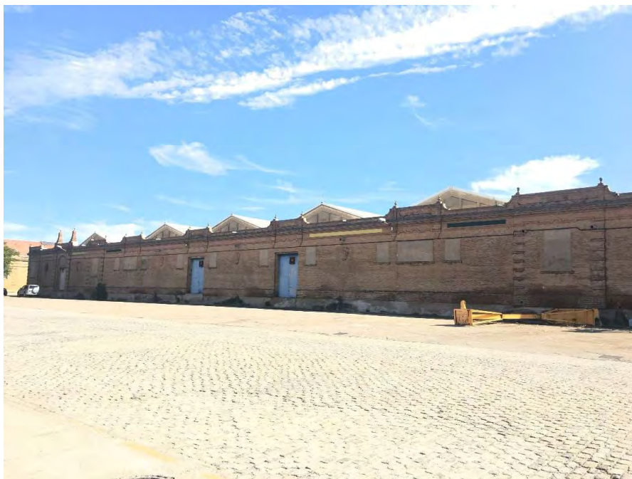
Vistas del cantil del muelle
