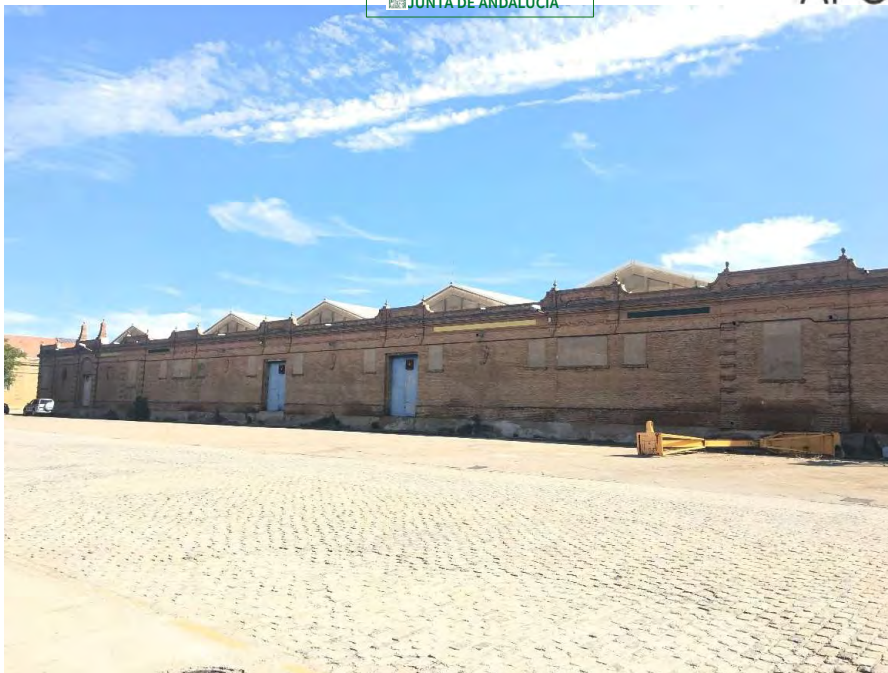
Vistas del cantil del muelle
