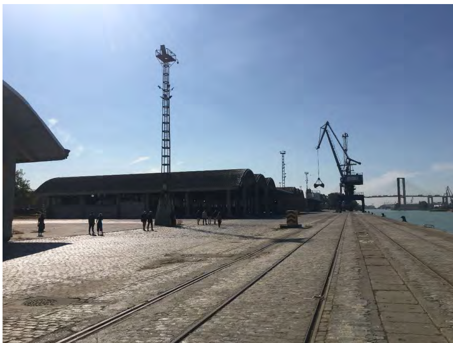
Vistas del cantil del muelle
