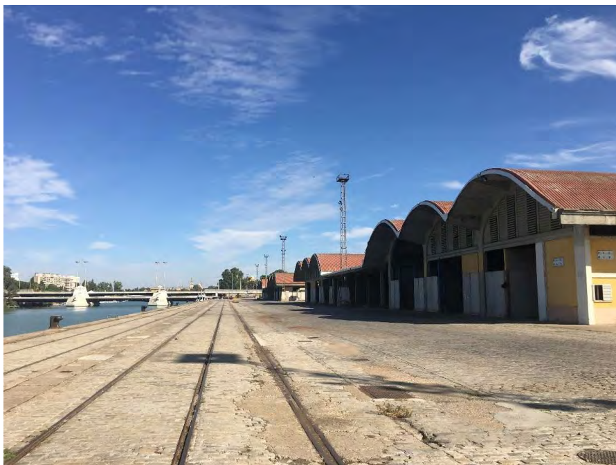
Vistas del cantil del muelle
