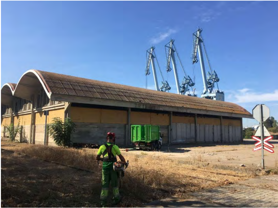
Estado actual de la Avda. del Guadalhorce
