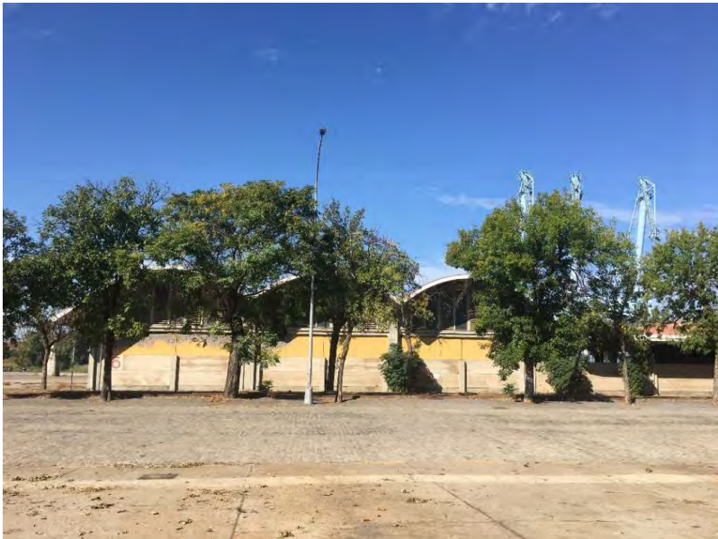
Estado actual de la Avda. del Guadalhorce
