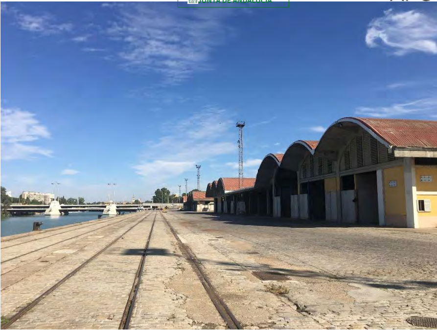
Vistas del cantil del muelle
