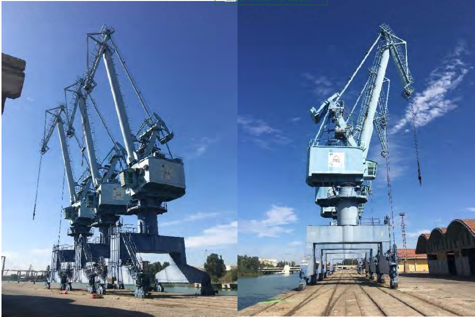
Vista de las grúas
