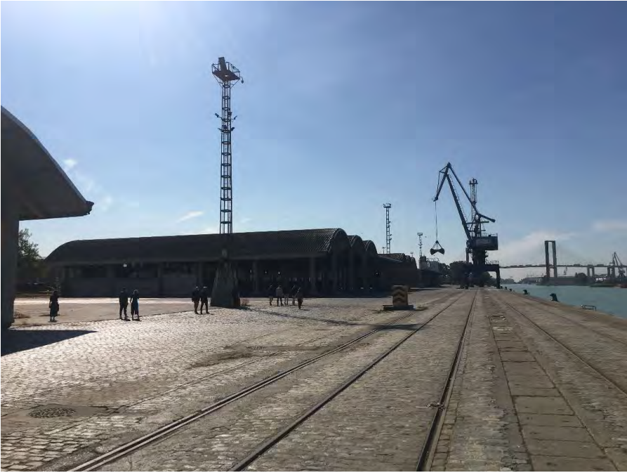
Vistas del cantil del muelle
