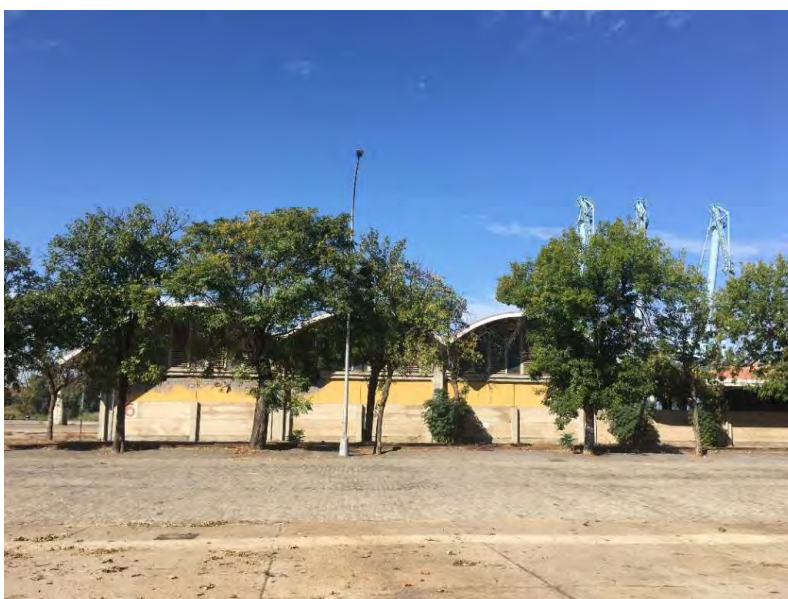
Estado actual de la Avda. del Guadalhorce
