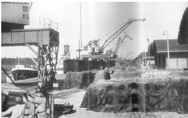
Imagen 25. El andén de costa del muelle de Tablada, ca. 1928. Aparecen las primeras grúas en operación, cuyo alcance coincide con la línea de fachada de los tinglados. Fuente: AHPs.
