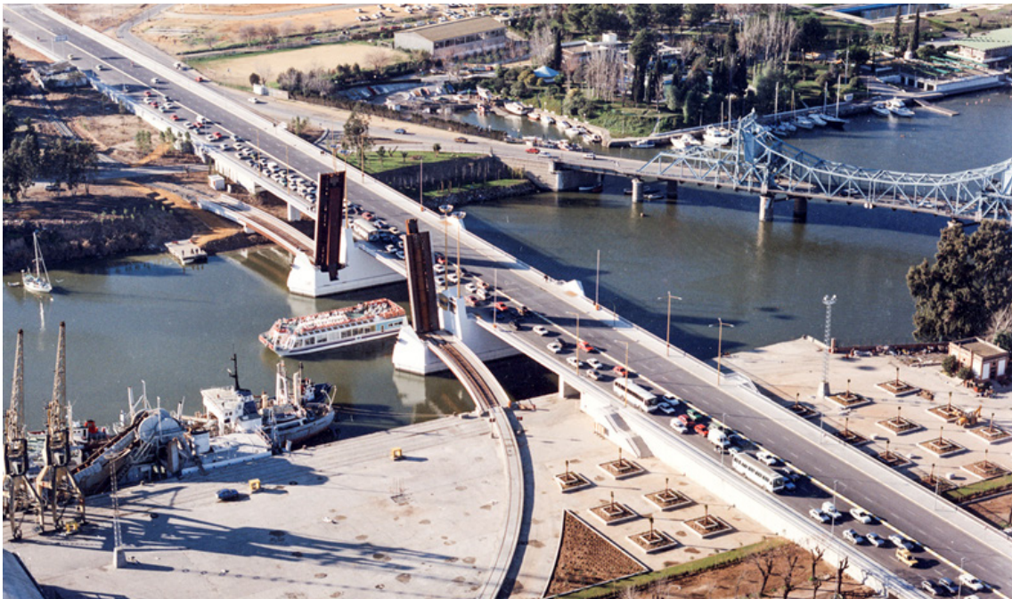
Imagen 02. Puentes de Alfonso XIII y de las Delicias Fuente: Carlos Fernandez Casado, S.L. ( https://www.cfcsl.com/puente-basculante-sobre-el-rio-guadalquivir-sevilla-espana-1991/ )
