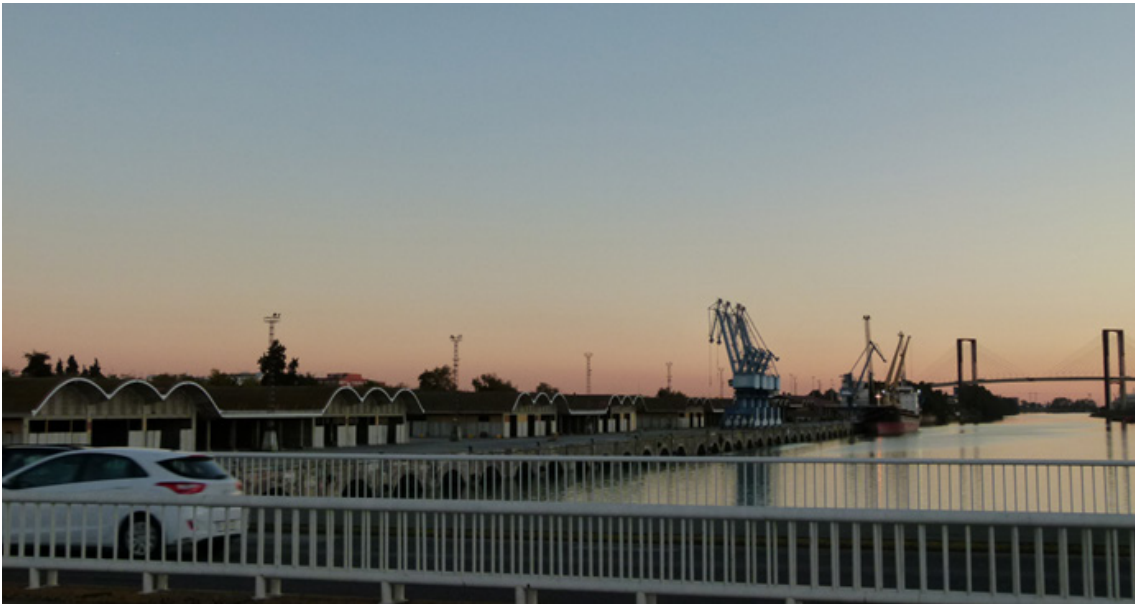
Imagen 07. Vista del muelle de Tablada mientras se circula por el puente de las Delicias. Fuente: Elaboración propia
