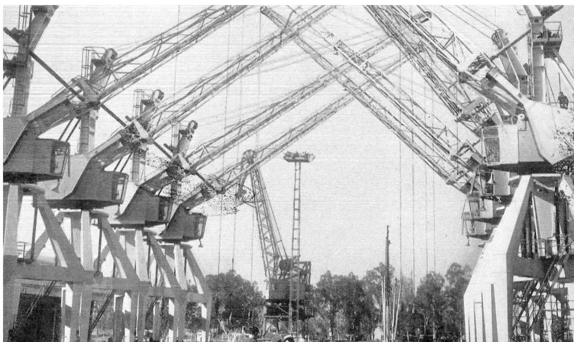
Imagen 44. Montaje de 8 nuevas grúas de pórtico doble para el muelle de Tablada en 1967. Fuente: Memoria anual del Puerto de Sevilla, año 1967, AHPS.
