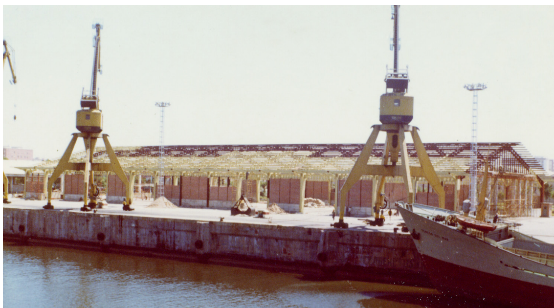
Imagen 48. El tinglado 11 en construcción en la ampliación del muelle. Ca. 1970. Fondo APS
