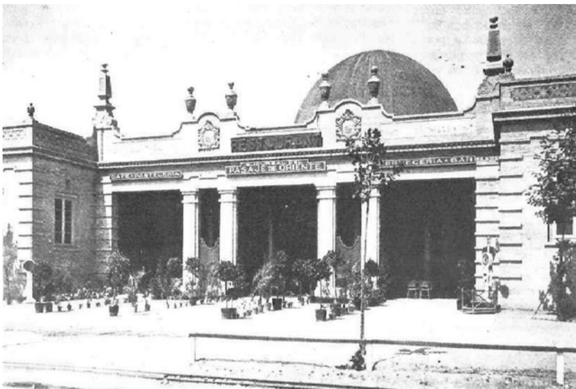
Imagen 36. Restaurante Pasaje de Oriente entre los almacenes de la avenida de La Raza, mediante la instalación de una pieza central. El interior era eminentemente diáfano, con pilares en los que se apoyaba la distribución de los diferentes usos. Fuente: extraído de Centro Andaluz del Libro 1990.
