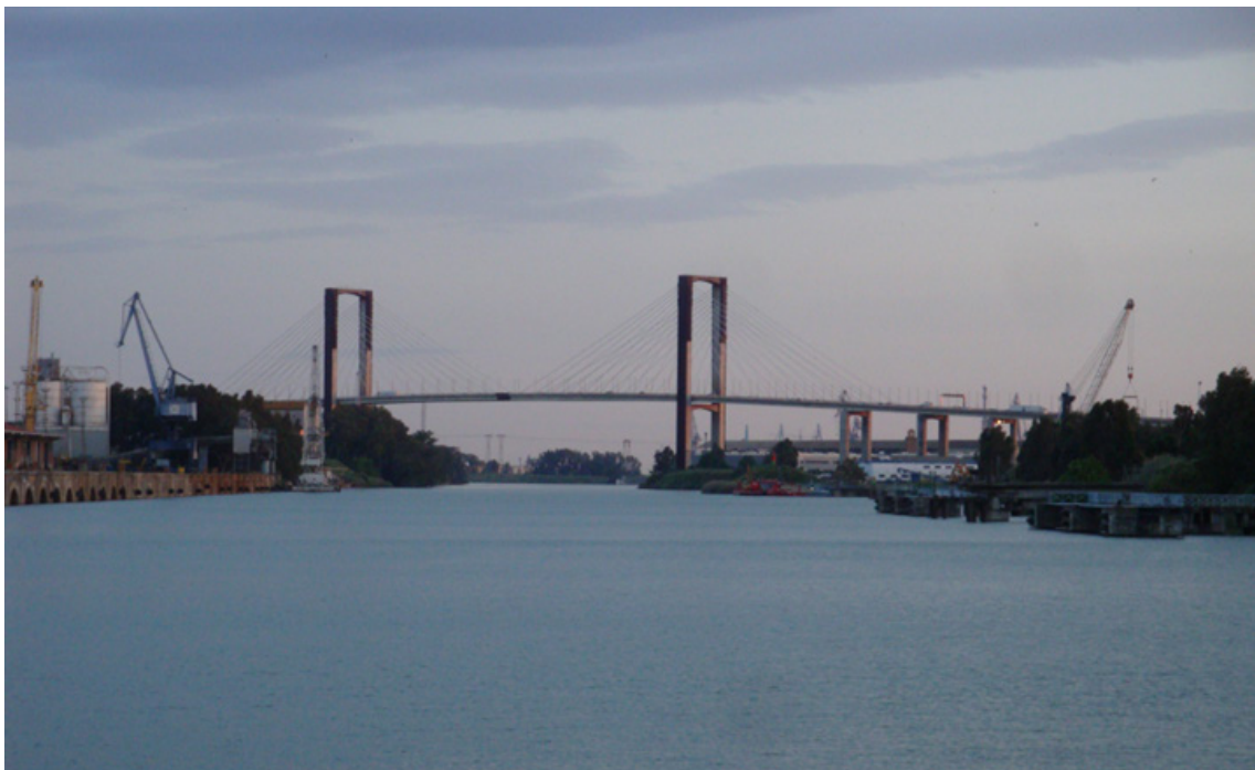
Imagen 03. Vista del puente del Centenario desde el río. Fuente: Elaboración propia
