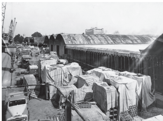
Imagen 45. Cubrición del patio entre los tinglados 3 y 4. S/F. Fuente: AHPS.
