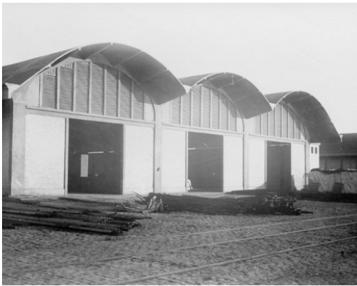
Imagen 31. Tinglados del muelle de Tablada, ya con cerramientos incorporados (S/F). Fuente: AHPS.
