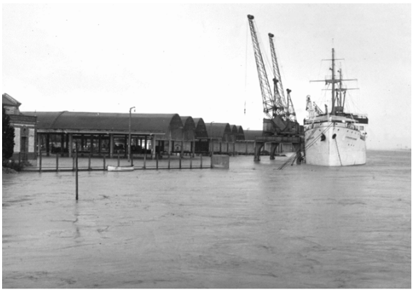
Imagen 32. El muelle de Tablada, inundado. ¿1961?. Las inundaciones se habían previsto como eventualidad, pero los saltos de cota se diseñaron para quedar por detrás de los tinglados, juzgando que el obstáculo a la maniobra cotidiana era más desfavorable que el impacto de inundaciones ocasionales. Fuente: AHPS, PS194.
