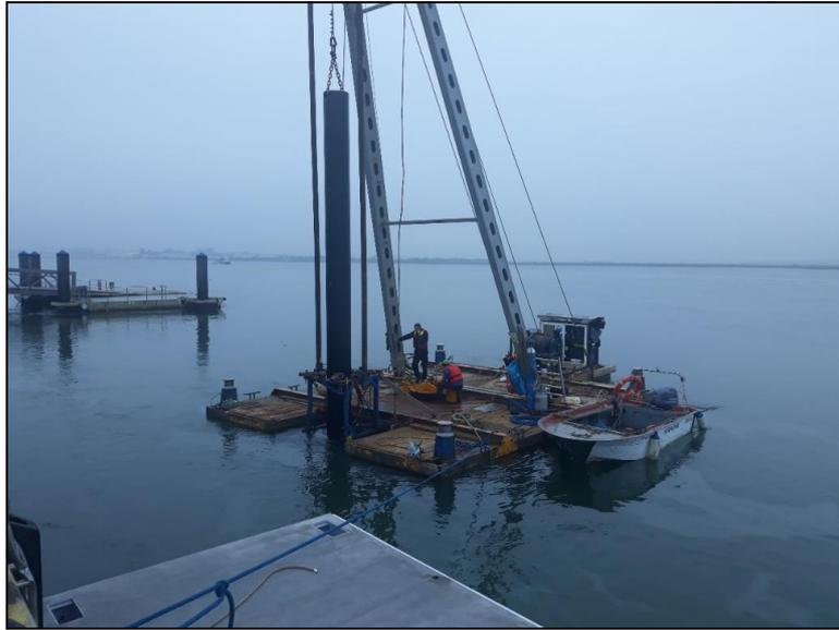
**Ilustración 7. Hinca de pilotes metálicos con pilotadora en plataforma flotante**
