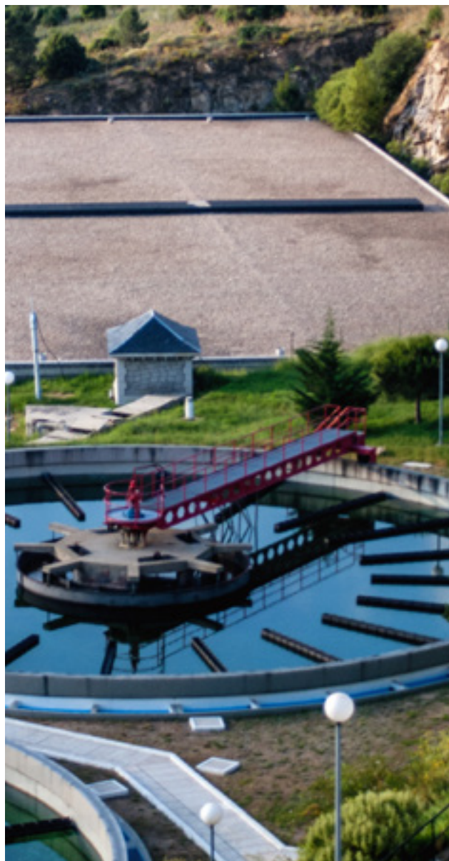
Depuradora de agua Adobe Stock
