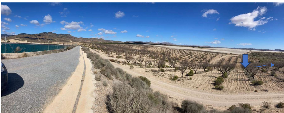
Imagen 20 – punto de desembocaduras de entubamientos y dirección de flujo. Fotografía orientada a Noreste.
