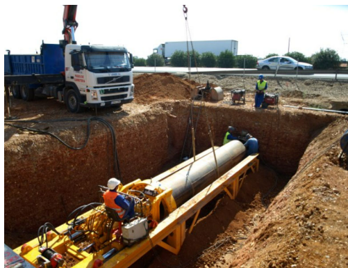
Figura 12: Ejemplo real de perforación encamisada bajo vial
