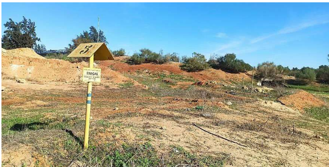
Fotografía 14. Gasoducto "Huelva - Sevilla - Villafranca de Córdoba - Santa Cruz de Mudela", al norte de la implantación fotovoltaica.
