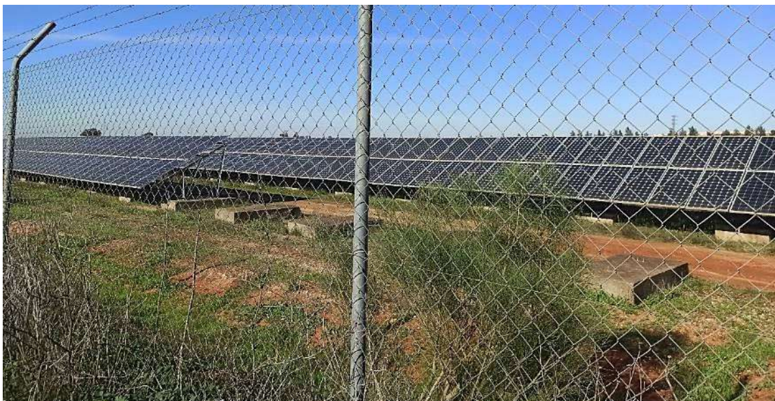
Fotografía 15. Planta Solar de tercero (S/N) identificada al noreste de la actuación "El Descubrimiento 90", cercada por un vallado metálico de simple torsión y tres hileras de espino.
