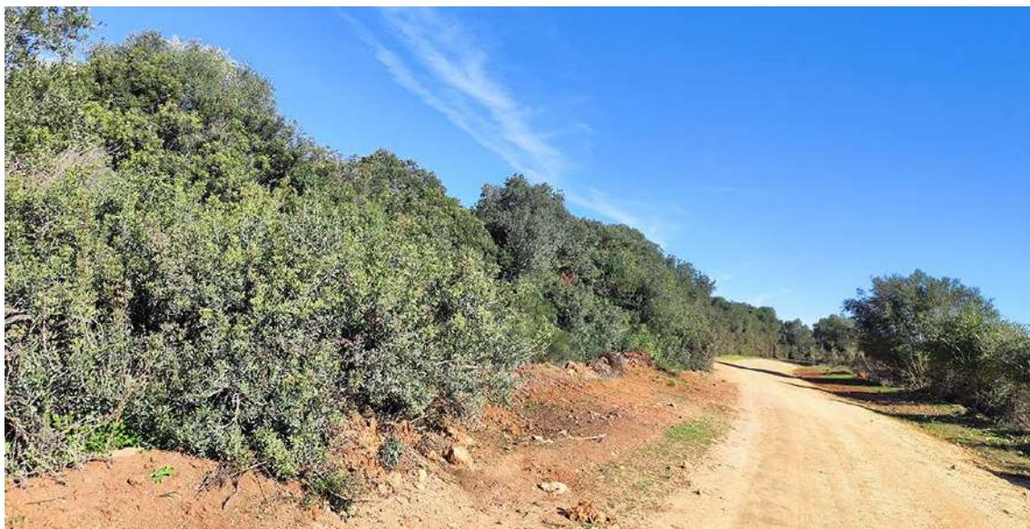
Fotografía 11. Barrera visual compuesta por un mosaico de vegetación natural dispuesta linealmente por toda la banda sur de la Planta Solar, a lo largo de toda la vertiente septentrional de la vía pecuaria "Colada de Las Plateras" (izquierda en la imagen).
