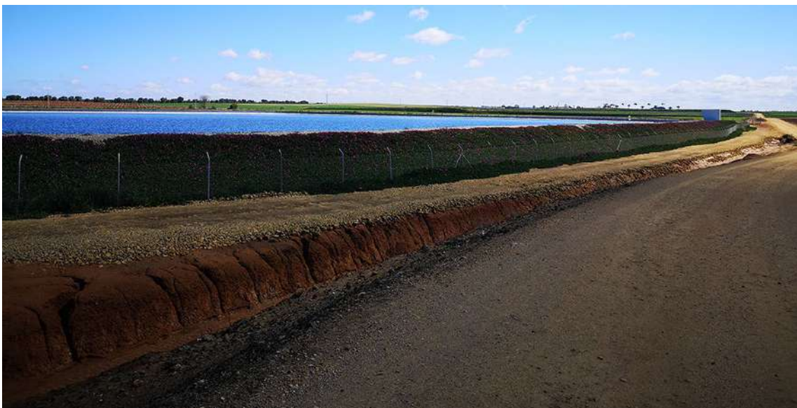
Fotografía 6. Balsa de riego en la finca Bujalmoro.
