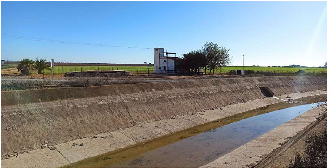
Fotografía 5. Canal del Bajo Guadalquivir, al oeste de la ubicación de la Planta Solar.
