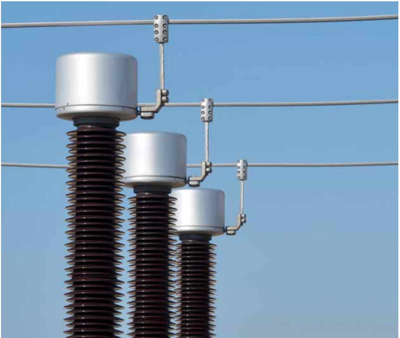
Los transformadores de tensión inductivos están diseñados para reducir las tensiones a valores manejables y proporcionales a las primarias originales, separando del circuito de alta tensión los instrumentos de medición, contadores, relés, etc.
