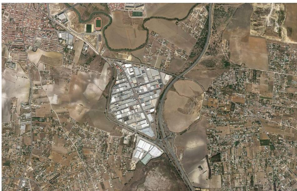
Fotografía aérea entorno próximo Polígono Industrial "Pelagatos".
