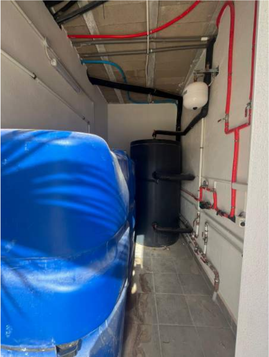
Fotografía 14: Cuarto de Instalaciones Edificio 1. Depósito acumulación Aerotermia y Aljibe AFS.
