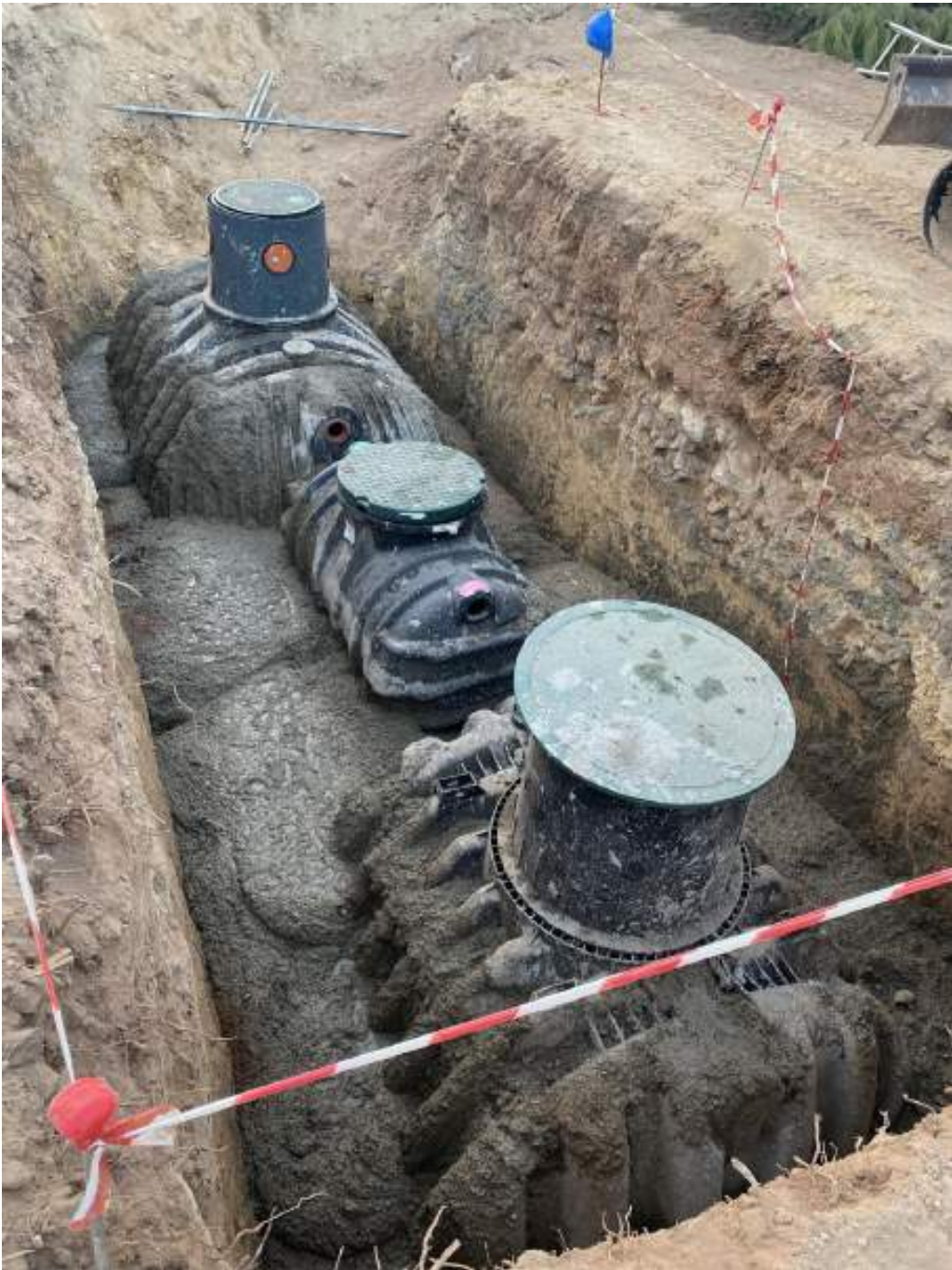
Fotografía 13: Fotografía de la ejecución de la depuradora de aguas fecales.
