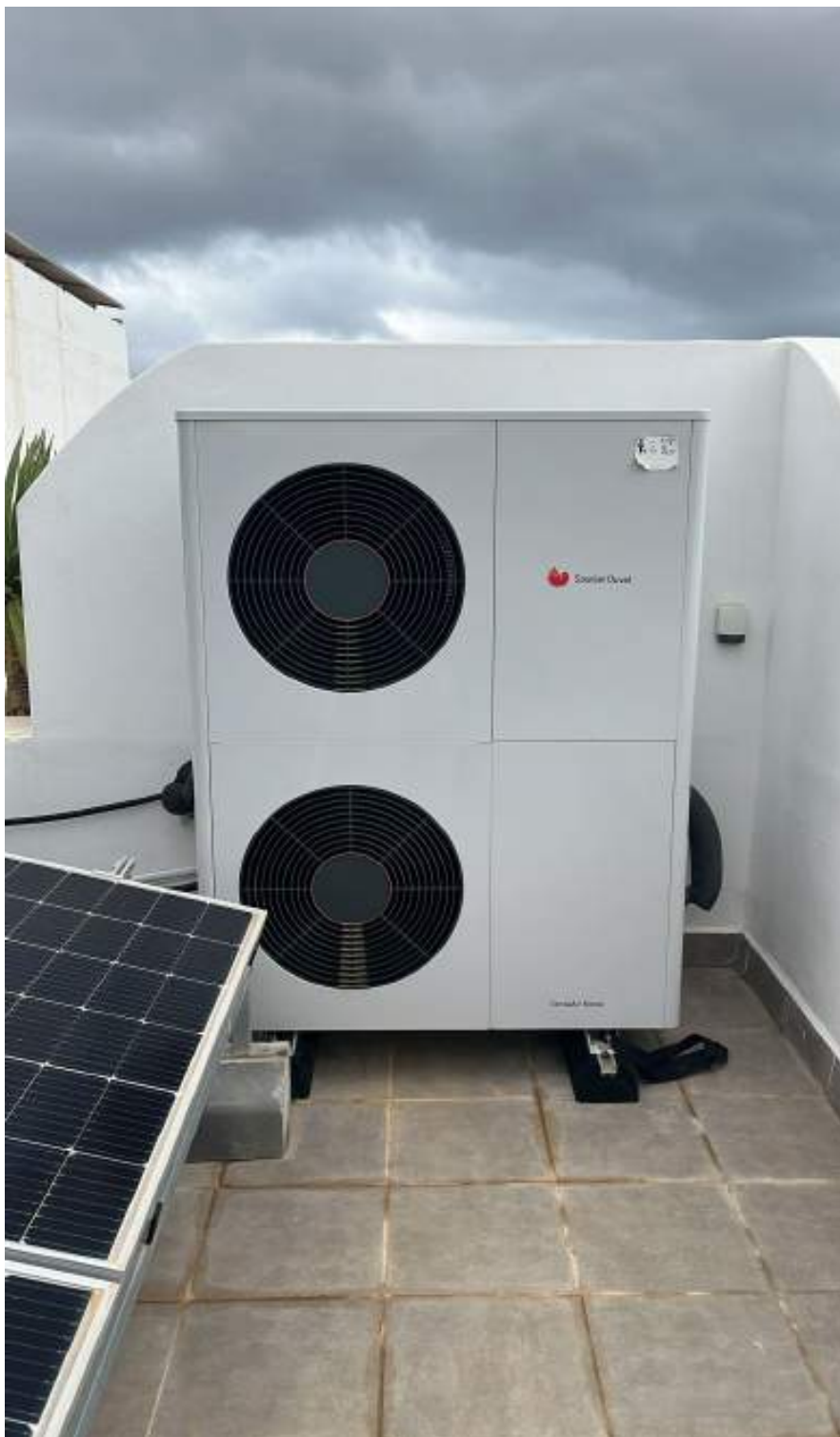
Fotografía 15: Unidad Exterior de Aerotermia e instalación fotovoltaica Edificio 1.
