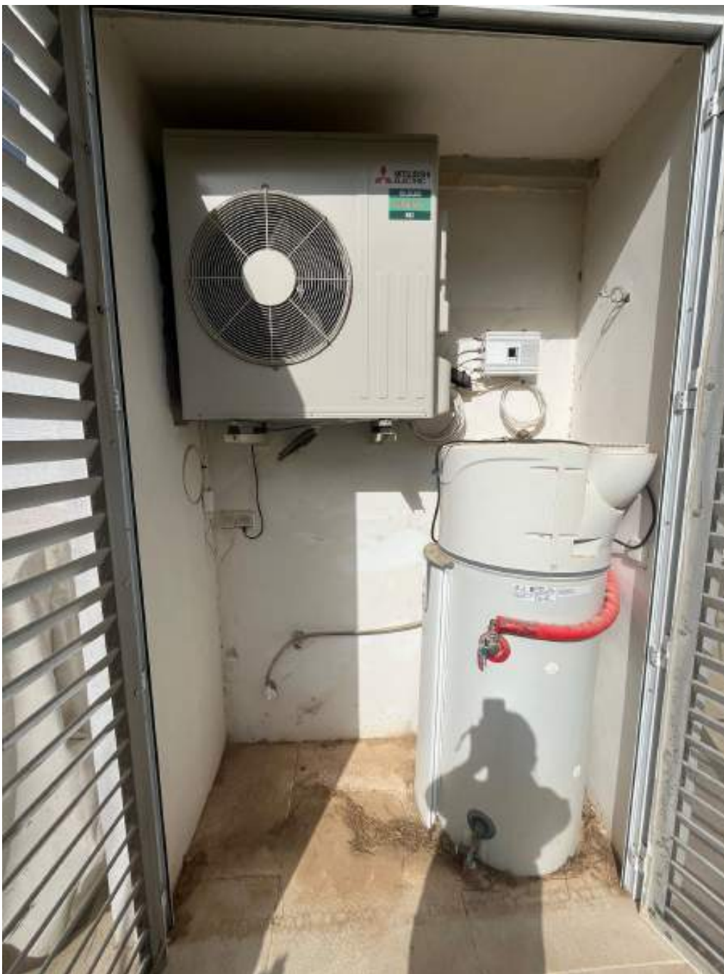
Fotografía 16: Cuarto de instalación de Aerotermita Edificio 2.
