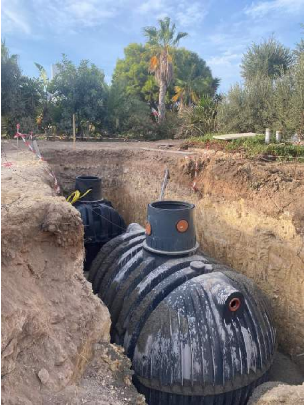
Fotografía 12: Fotografía de la ejecución de la depuradora de aguas fecales.
