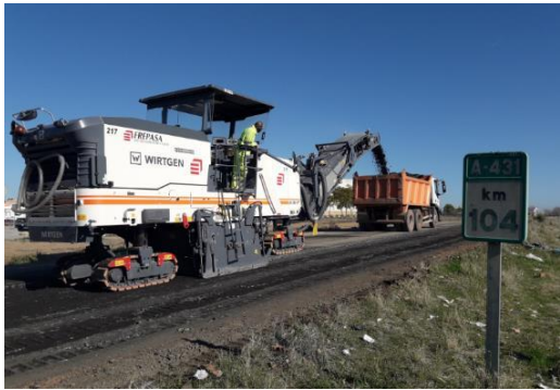
Figura 2. Foto genérica de una fresadora de pavimentos asfálticos
