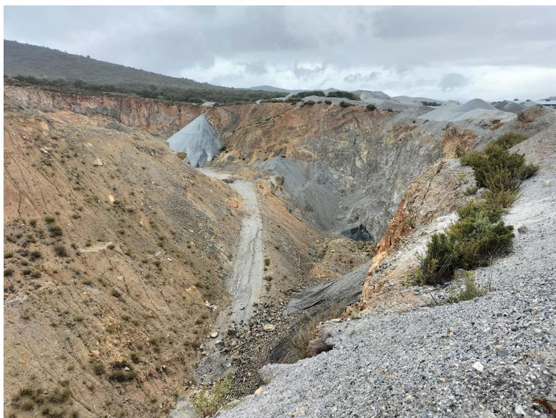
En esta fotografía se aprecia el hueco minero que se pretende rellenar con el aporte de tierras exterior. A la izquierda de la imagen se aprecia el material que se extraerá previamente, aumentando de esta manera el hueco minero y por lo tanto, la cantidad de material de aporte exterior necesario.
