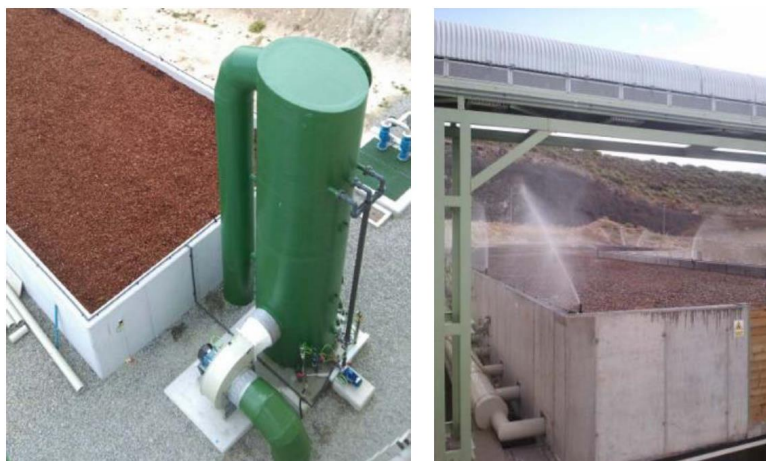
FIGURA 2.9 EJEMPLO DE SISTEMA DE DESODORIZACIÓN BIOLÓGICA Y SISTEMA DE RIEGO DEL LECHO (DCHA.)
