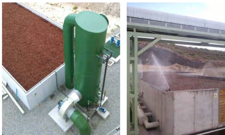
FIGURA 4.9 EJEMPLO DE SISTEMA DE DESODORIZACIÓN BIOLÓGICA Y SISTEMA DE RIEGO DEL LECHO (DCHA.)
