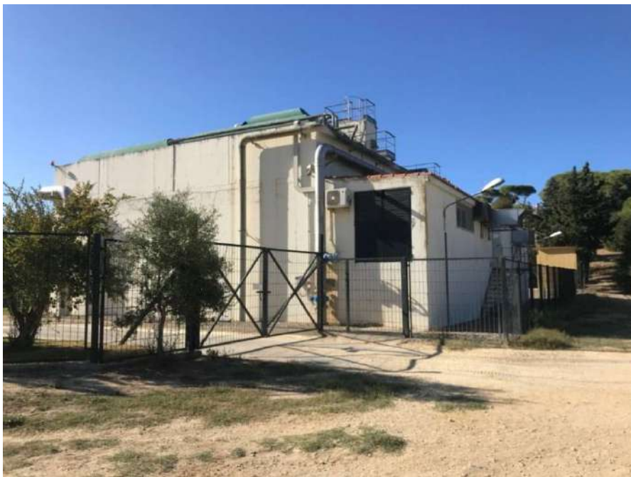
Foto nº 11. Portón de acceso a la EDAR.
