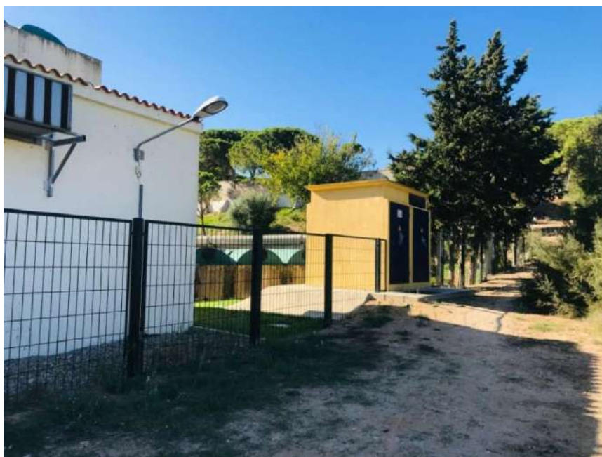
Foto nº 10. Visual del límite Oeste de la EDAR.
