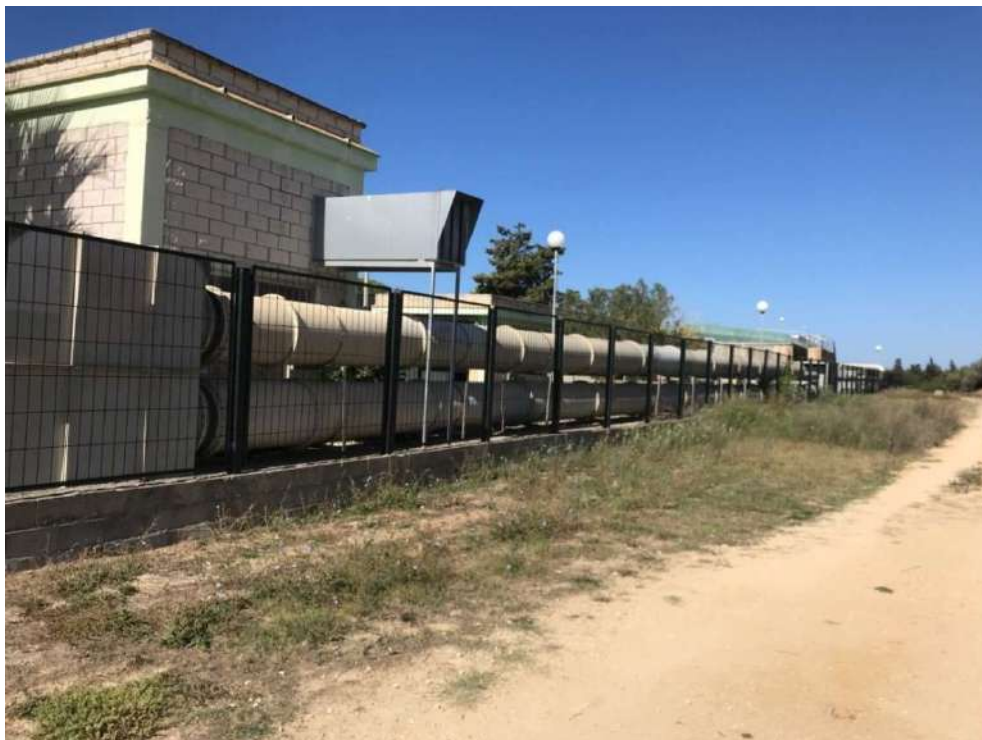
Foto nº 38. Fachada Norte de EDAR
