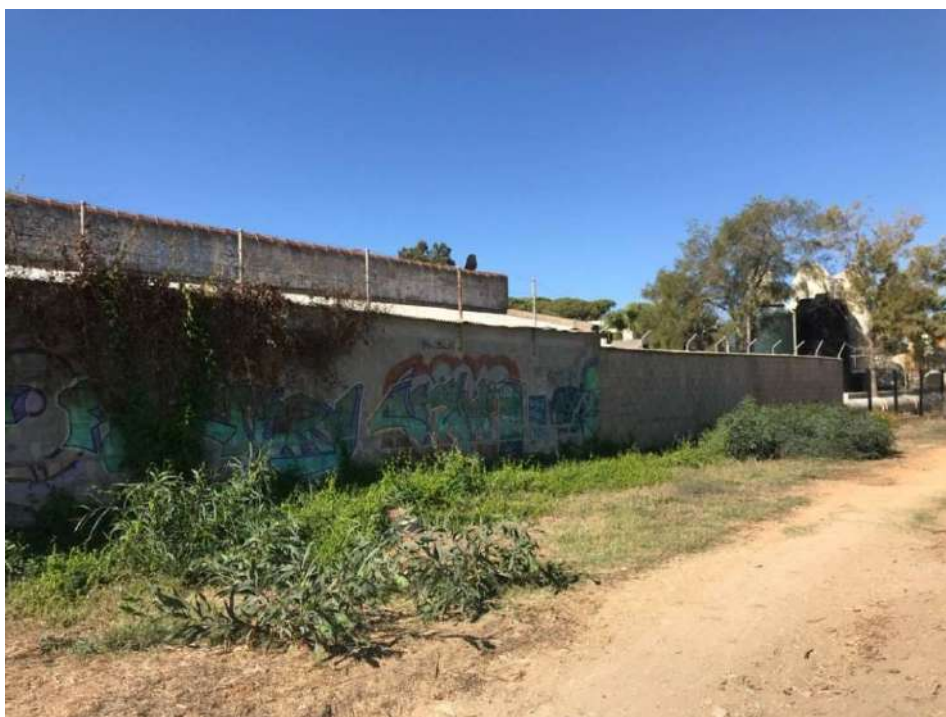
Foto nº39 . Fachada Norte de EDAR y de Colegio existente.
