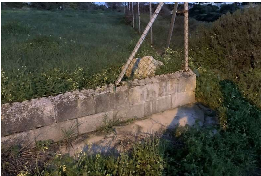
Foto nº 18. Muro y vallado a demoler y a sustituir por talanquera con acceso para puente
