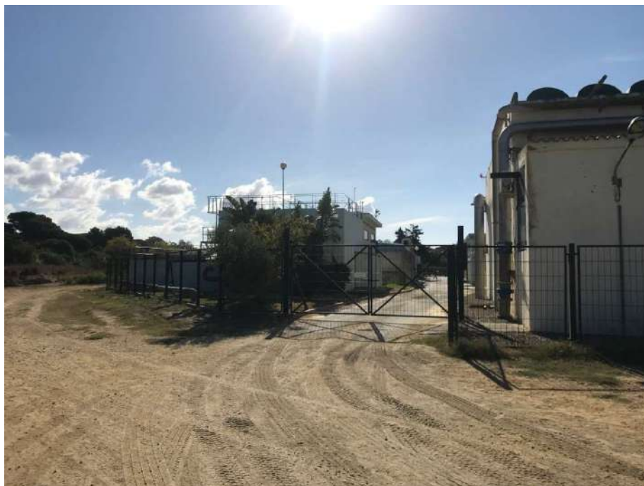
Foto nº 15. Acceso a la EDAR.
