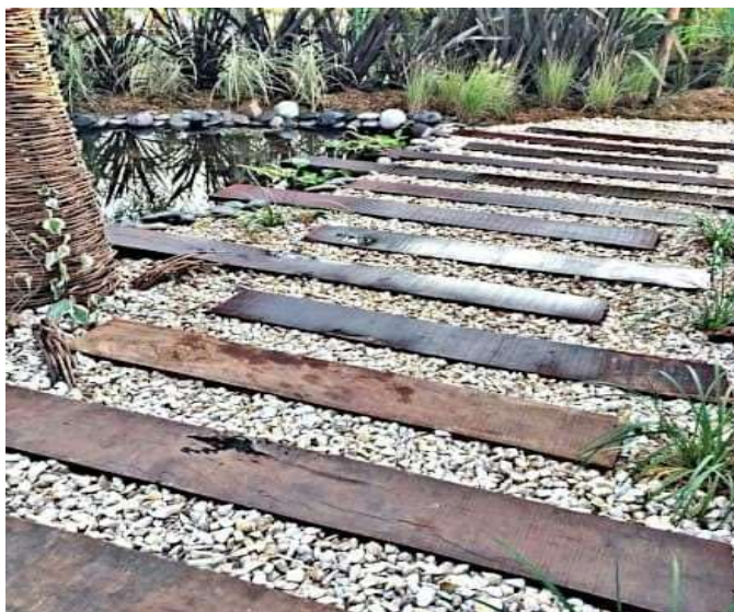
Ilustración nº 63. Diseño de caminos de traviesa y material granular. Fotos tipo.
