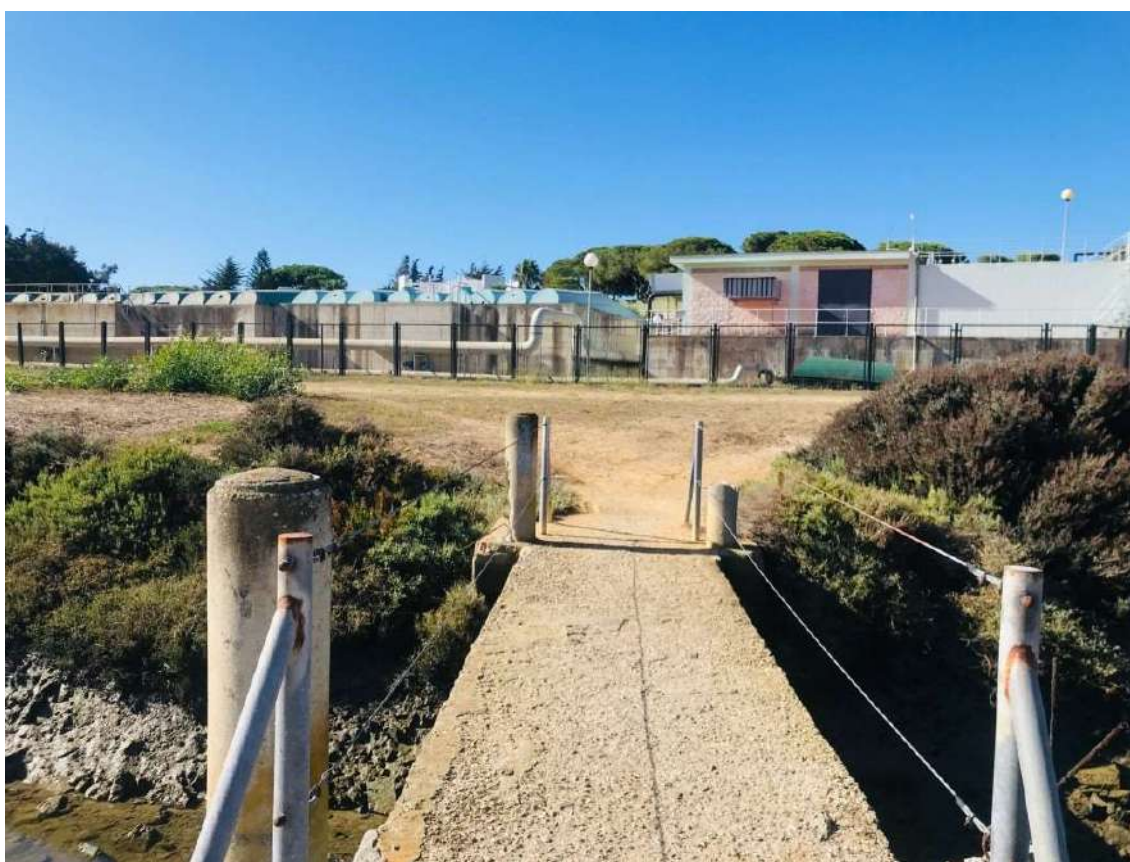
Foto nº 22. Estado actual del puente existente.
