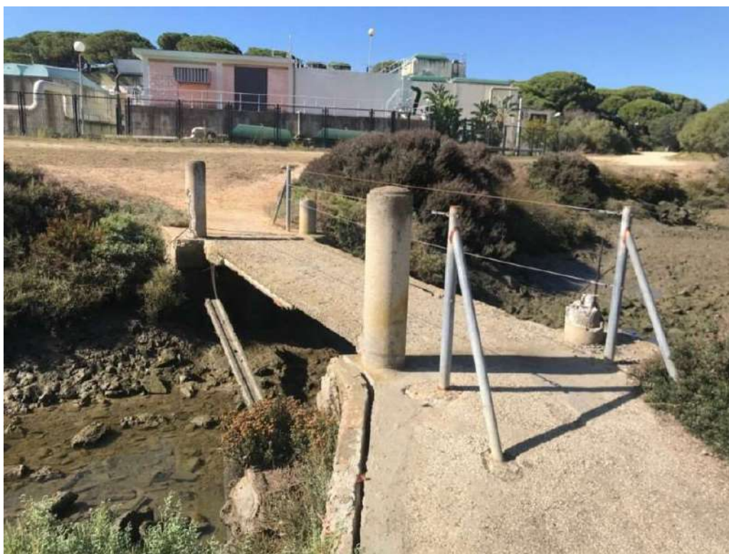
Foto nº 21 . Estado actual del puente existente
