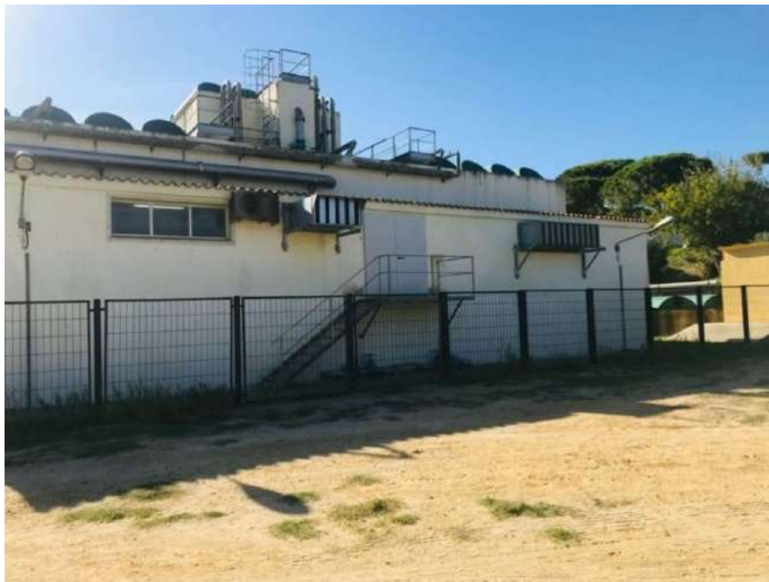
Foto nº 9. Visual del frontal del límite norte de la EDAR.
