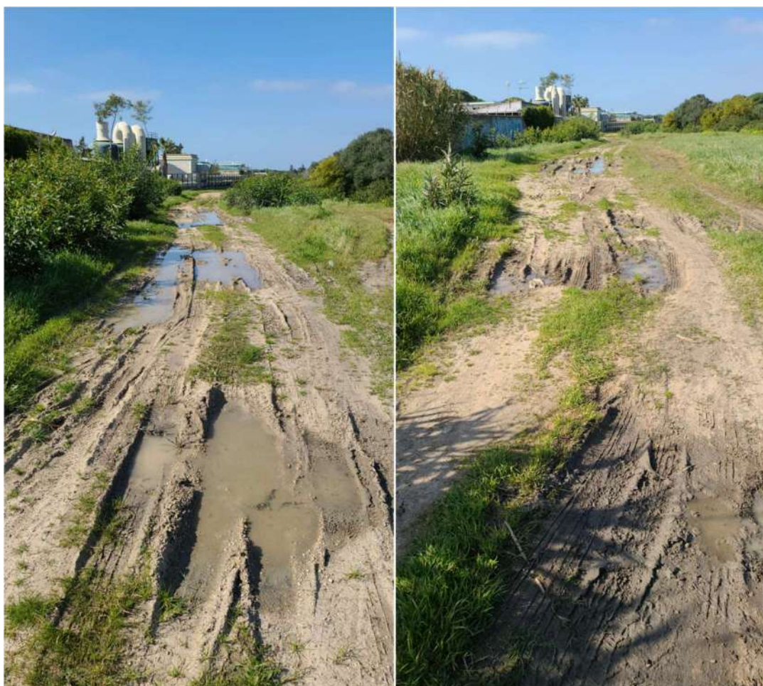
Foto nº 24-25. Estado actual camino principal y eje vertebral del parque
