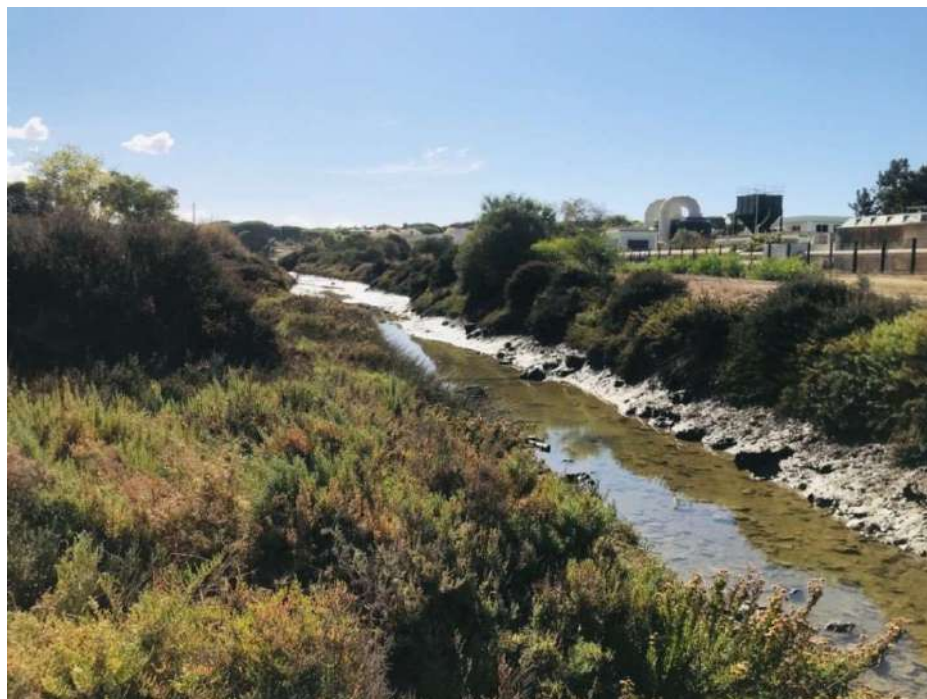
Foto nº 37. Visual del Río Carajolilla, zona donde se recomienda construir un puente en el futuro
