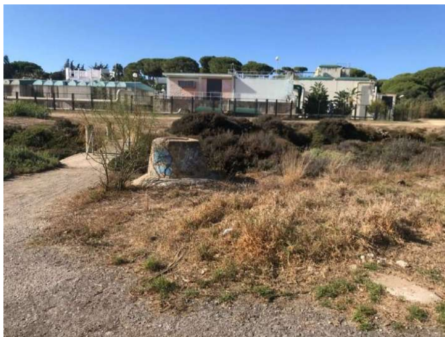
Foto nº 16. Visual de la depuradora desde el punto de acceso 2 del parque (donde está el puente)
