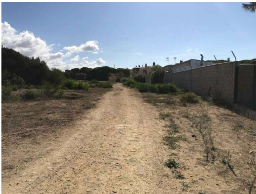
Foto 23. Camino principal y eje vertebral del parque, que ha de arreglarse mediante nivelación, compactación y aporte de zahorra
