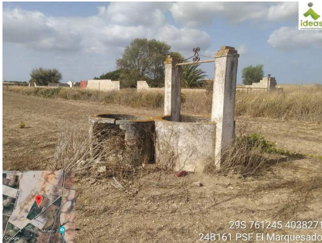
Fotografía 25. Revisión de puntos de agua para censo de herpetofauna en el ámbito de estudio. Septiembre de 2024.
