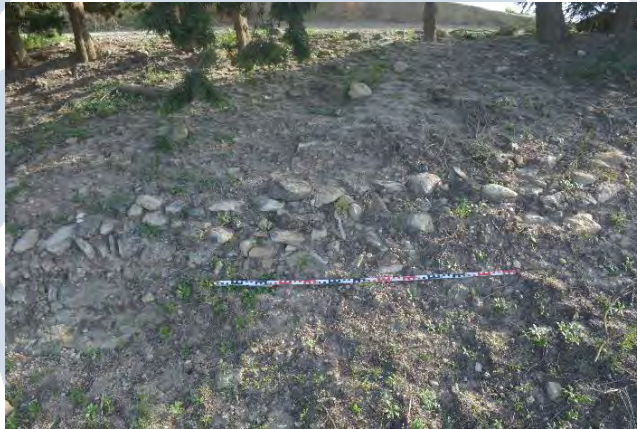
Figura 41 Imagen del muro
