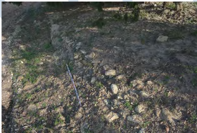
Figura 42 Vista de muro de piedra
