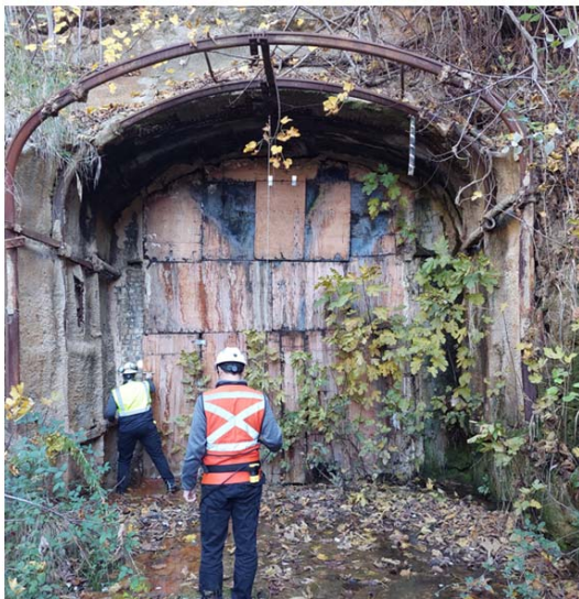
Acceso a la antigua galería de Boliden y estado interior deteriorado del sostenimiento de cuadros metálicos y chapas Bernold en su interior lógico dada la antigüedad de la infraestructura.
