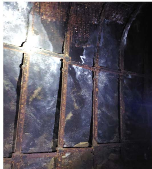
Acceso a la antigua galería de Boliden y estado interior deteriorado del sostenimiento de cuadros metálicos y chapas Bernold en su interior lógico dada la antigüedad de la infraestructura.
