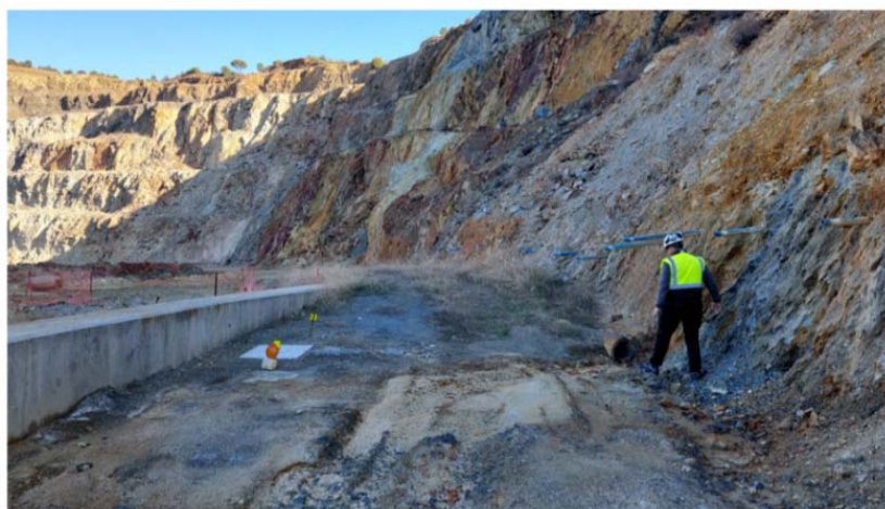
Medidas de estabilización (pantalla de micro-pilotes y drenaje) y control (inclinómetro) de una zona de talud potencialmente inestable al este de la corta de Los Frailes
