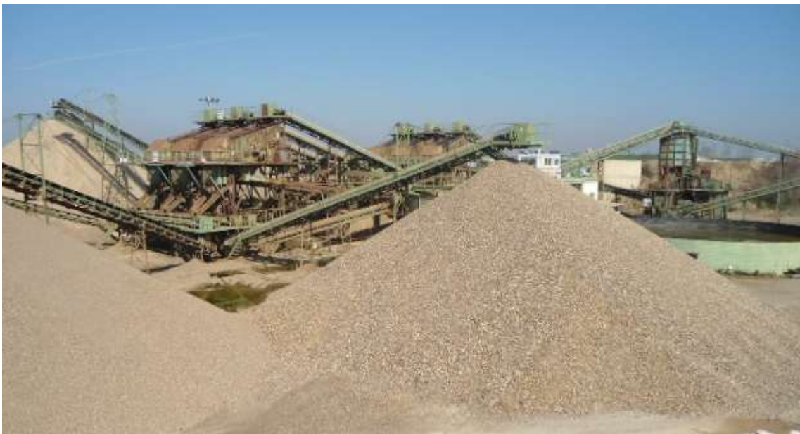
Figura 14: Vista general planta de tratamiento de áridos o establecimiento de beneficio.
