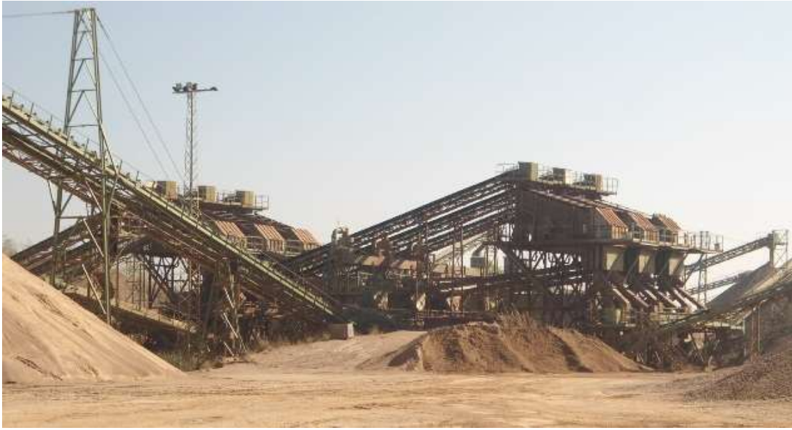
Figura 13: Vista general planta de tratamiento de áridos o establecimiento de beneficio.
