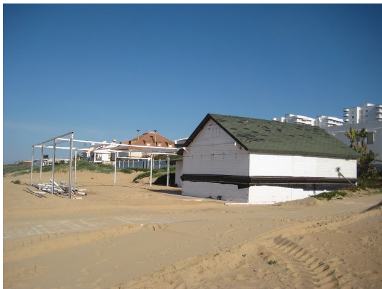
VISTA SURESTE DE LA INSTALACIÓN.
