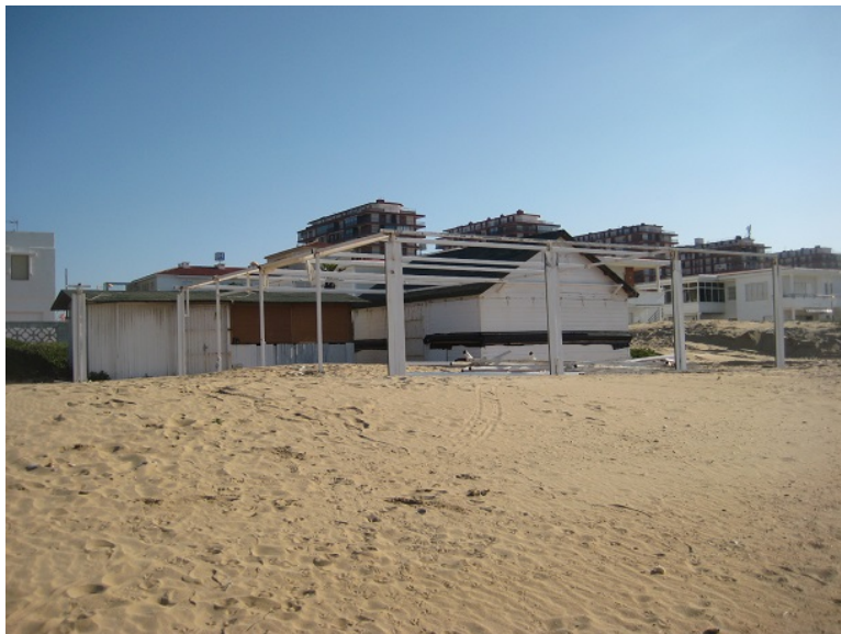
VISTA OESTE – TERRAZA ABIERTA
