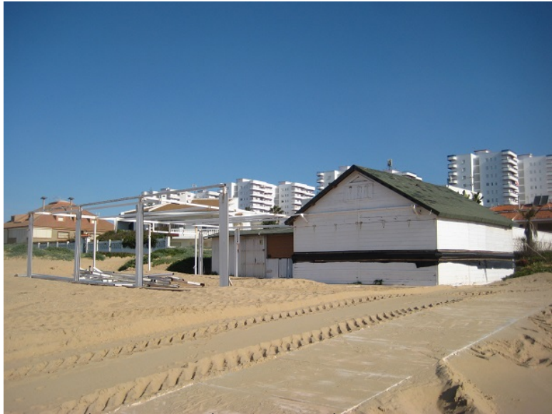
REDUCCIÓN DE SOLERÍA Y CUBRICIÓN EN TERRAZA ABIERTA
