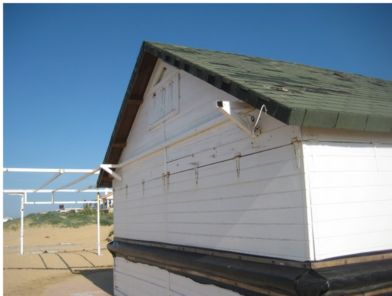
CUBRICIÓN TERRAZA - ESTRUCTURA METÁLICA REDUCIDA.
