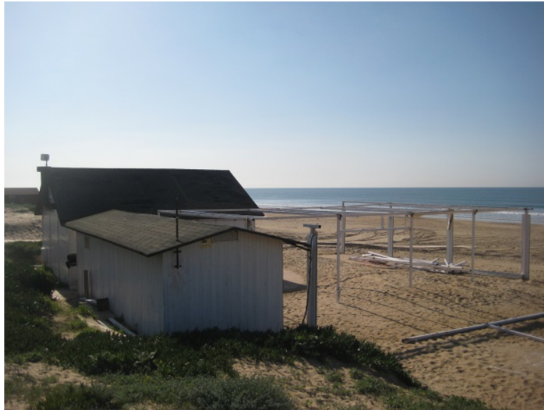
TERRAZA DESMONTADA FRENTE AL MÓDULO AUXILIAR
