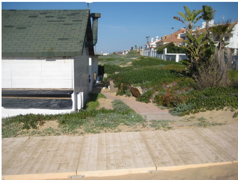
PASARELA DE ACCESO A LAS ASEOS DE USO PÚBLICO
