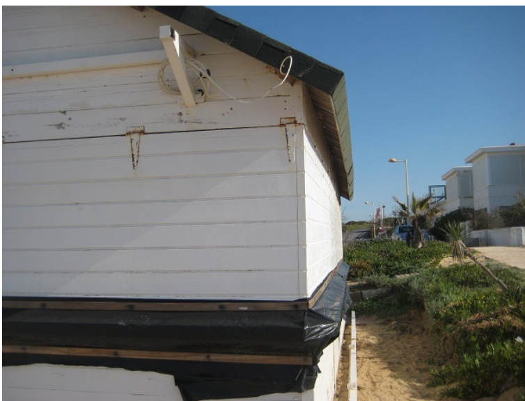
TRAMO DE SOLERÍA DESMONTADA EN EL LATERAL DE LA EDIFICACIÓN CERRADA
