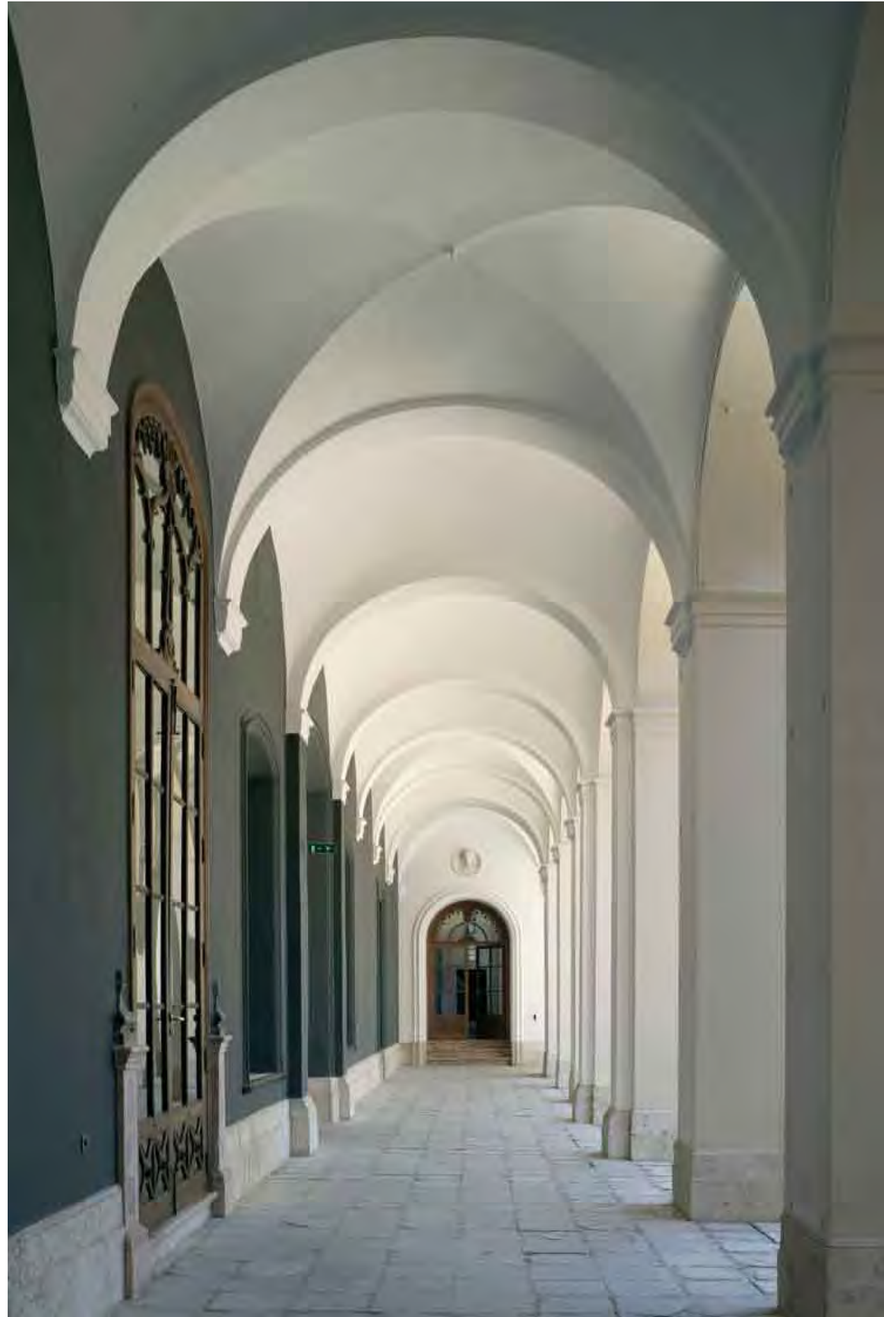
Patio de honor y galería porticada que recorre longitudinalmente todo el edificio. Los nuevos colores blanco y gris pertenecen a esta intervención.
