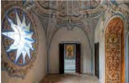
Espacio del camarín de la Virgen del Buen Aire antes y después de su restauración.
