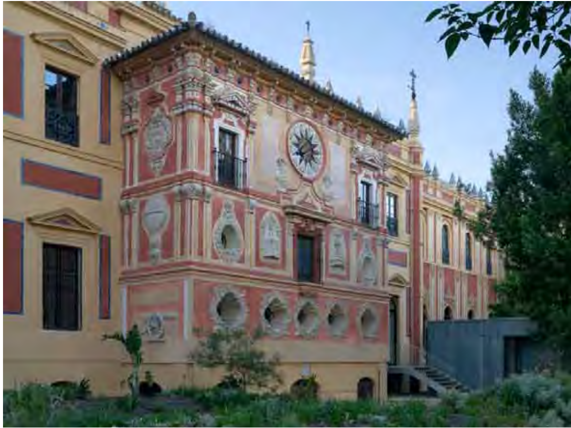
Fachada al jardín del camarín de la Capilla y del Salón de Recepciones.
