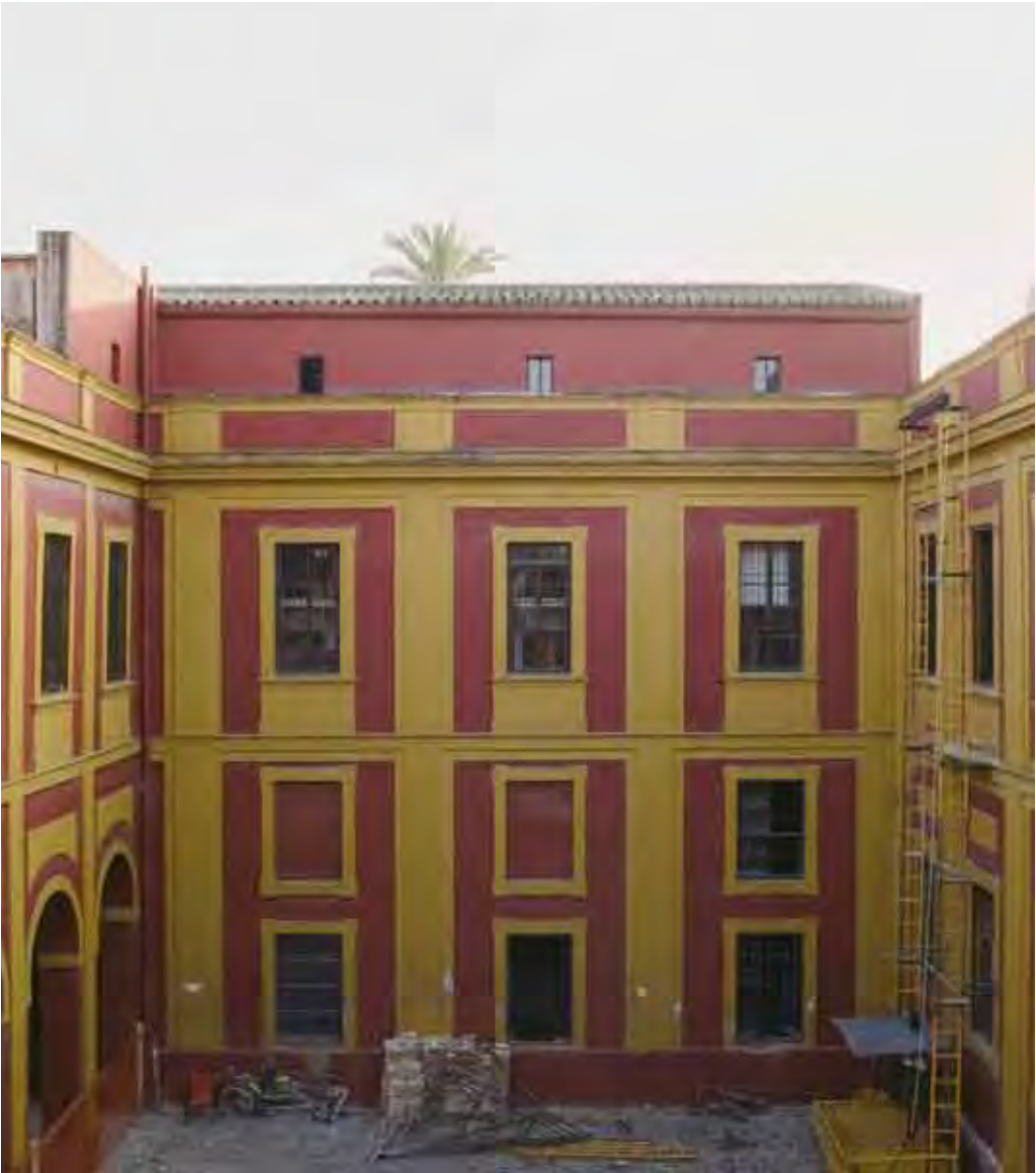
Intervención de Galnares Sagastizábal en uno de los patios del Apeadero, con la tercera planta de camarillas sobre el pretil de la cubierta.
