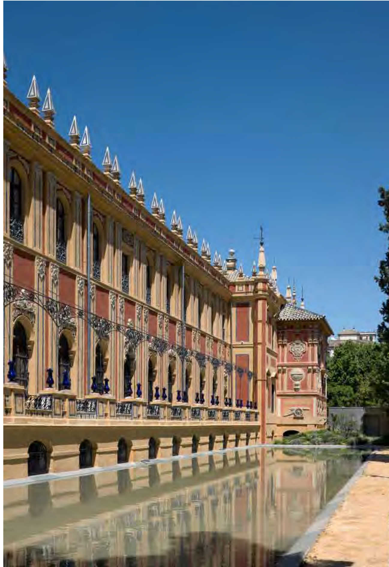
Fachada al jardín con el estanque sobre la galería subterránea de instalaciones. La lámina de agua se sitúa a la altura de la vista desde la cripta del Palacio.
