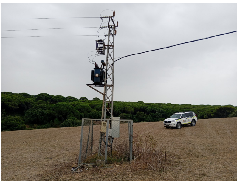
Localización e inspección de una torreta eléctrica por un equipo de Medio Ambiente
