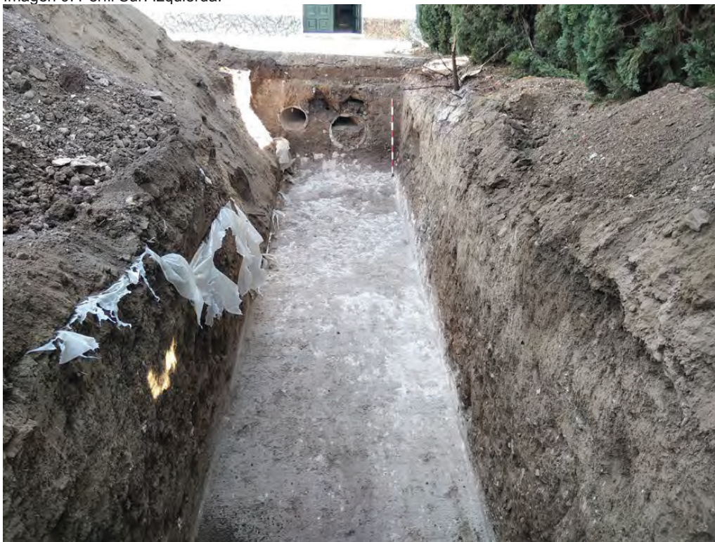
Imagen 10. Ampliación hacia el Sur Sondeo 1.
