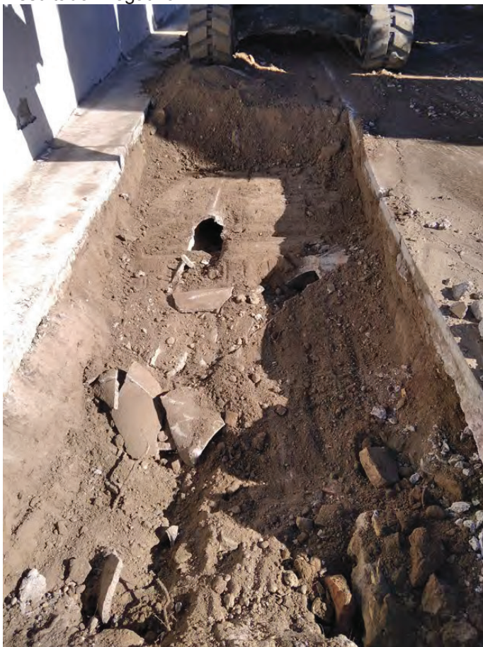
Imagen 12. Estado inicial Sondeo 2
