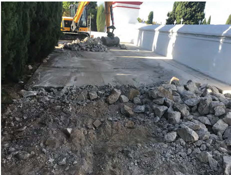
Imagen 3. Estado inicial Sondeo 1
