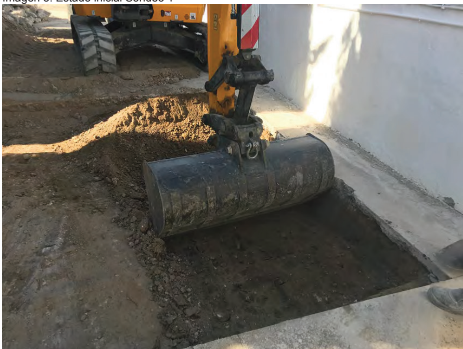
Imagen 4. Estado inicial Sondeo 1
