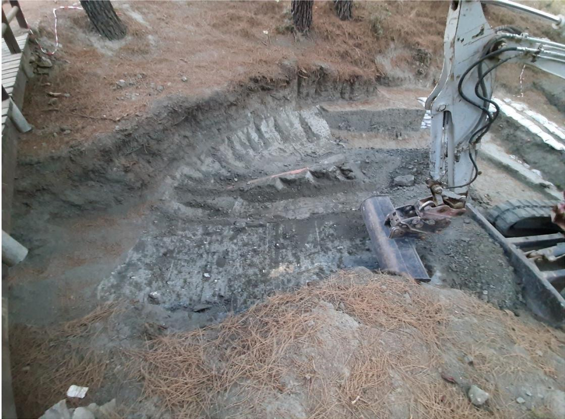
IMAGEN 5.85. Rebaje con máquina retroexcavadora en la parte sureste de la zona 1
