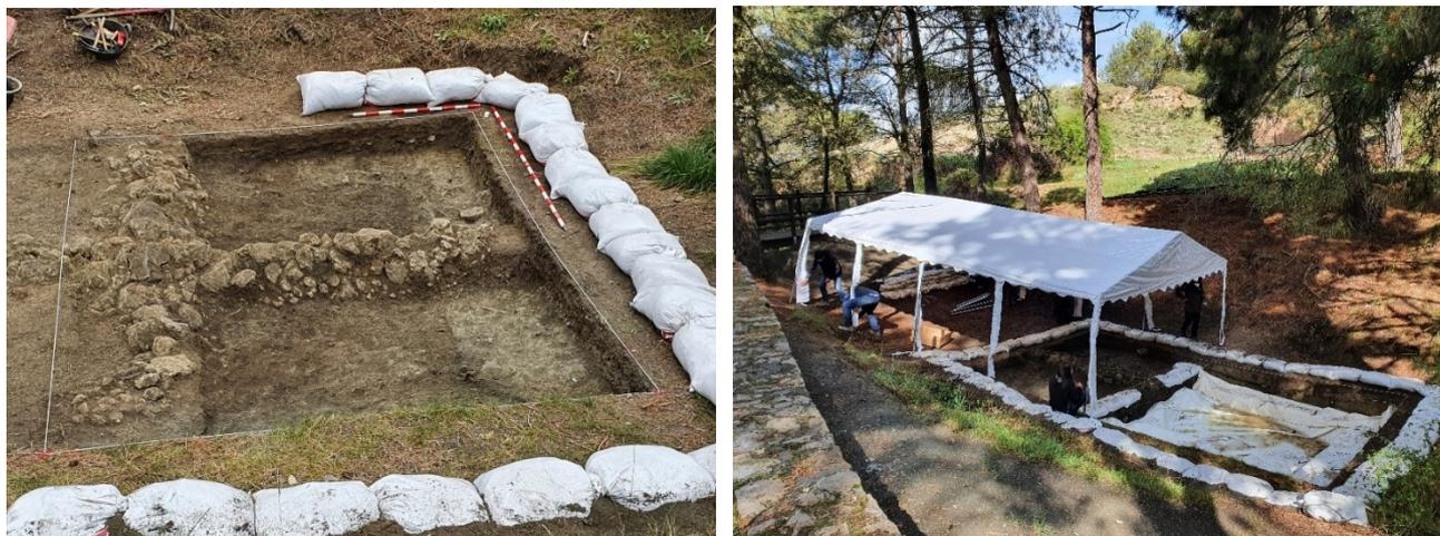
FIGURA 5.8. Montaje de perímetro de control de aguas de escorrentía y primeras fases de montaje de la cubierta sobre el Sondeo 1
