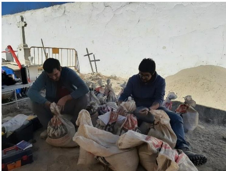
Figura 4.25.- Llenado de sacos terreros y realización de caballones para evitar la entrada de agua en la zona de trabajo.
