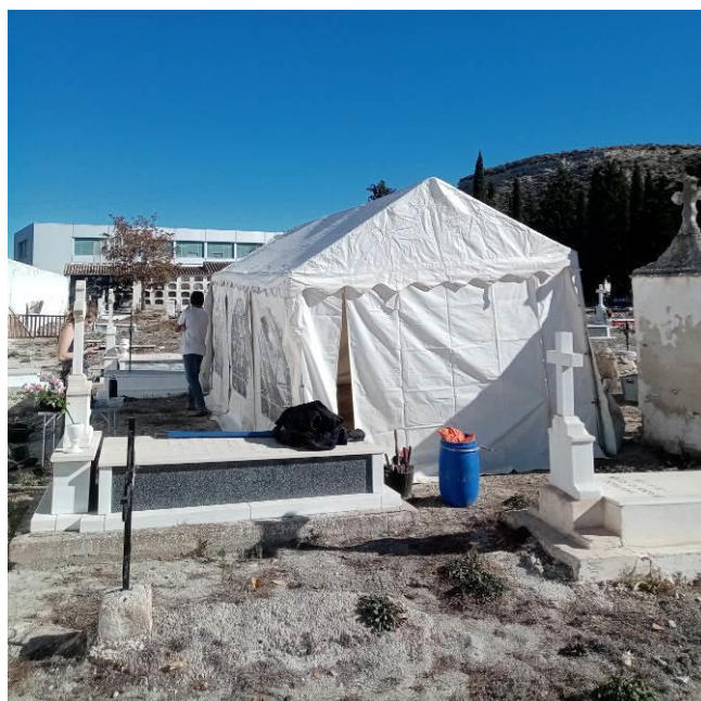
Figura 4.23.- Cubierta de protección del Sondeo 1 totalmente instalada.
