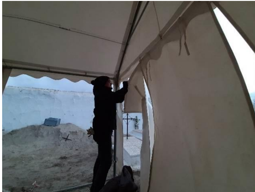
Figura 4.21.- Colocación de lonas laterales para la protección de la zona de trabajo.
