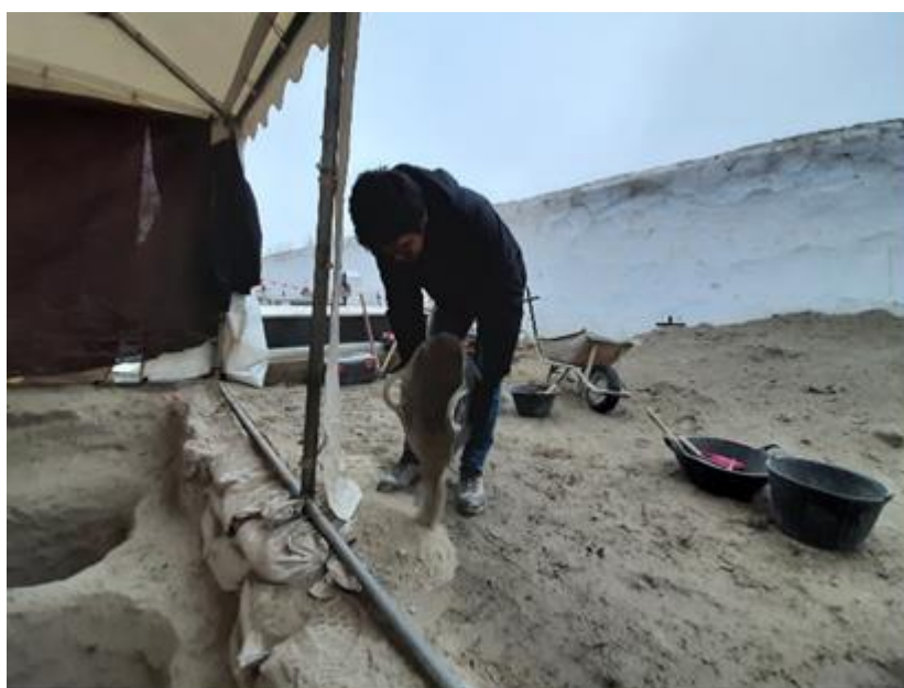
Figura 4.24.- Realización de caballones para evitar la entrada de agua en la zona de trabajo.
