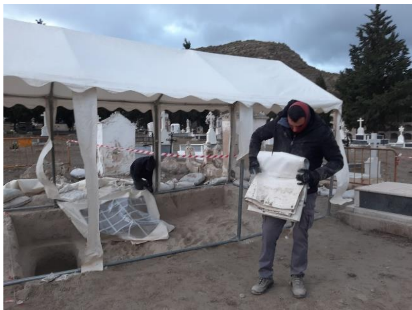
Figura 4.20.- Montaje de la carpa de protección del área de trabajo.
