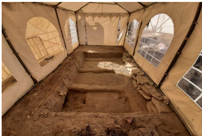
Figura 4.42.- Adecuación de los espacios y preparación para la ampliación del Sondeo 1.
