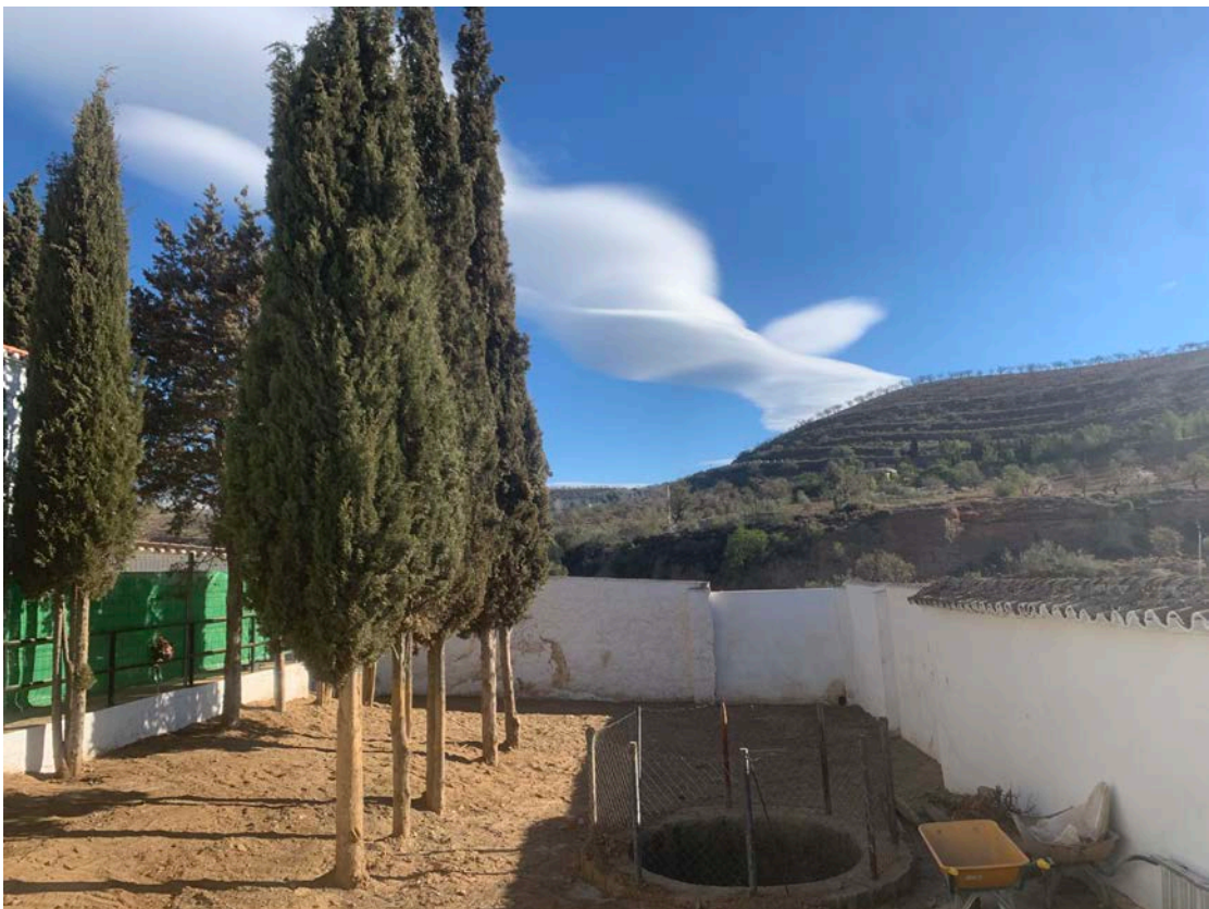
Fig. 4.151 – Restauración del volumen original del área de excavación.
