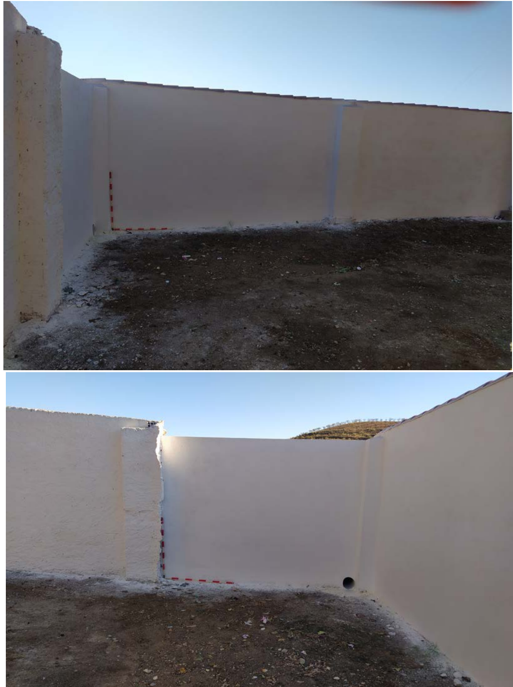
Figura 4.38 – 4.39 -Vista interior antes del comienzo de los trabajos. Vemos el nivel interno del desagüe y las hiladas de muro de reciente factura
