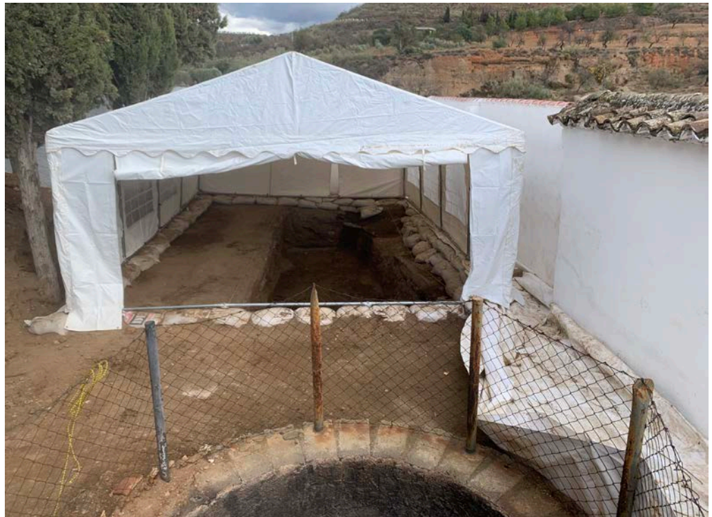
Fig.4.60 – 4.61 -Finalización del montaje de la carpa de protección y de las cubiertas de desagüe
