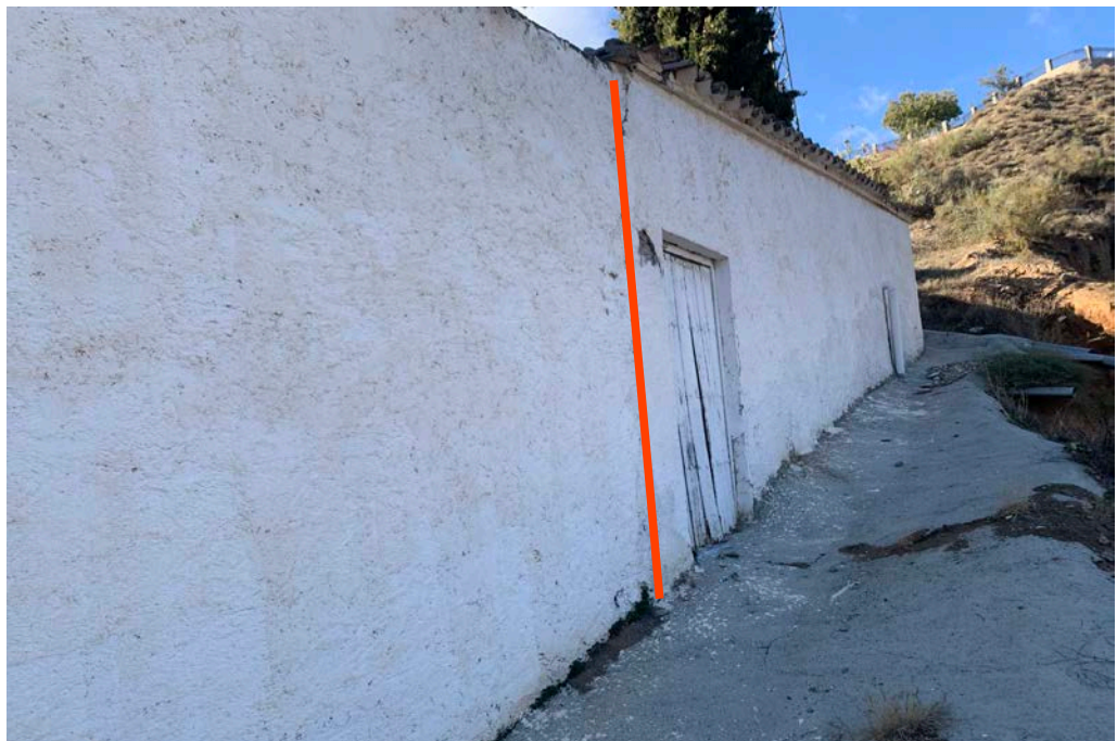
Figura 4.34 - Antigua puerta de acceso al cementerio civil. Se puede observar la diferencia de materiales y factura de ambos muros
