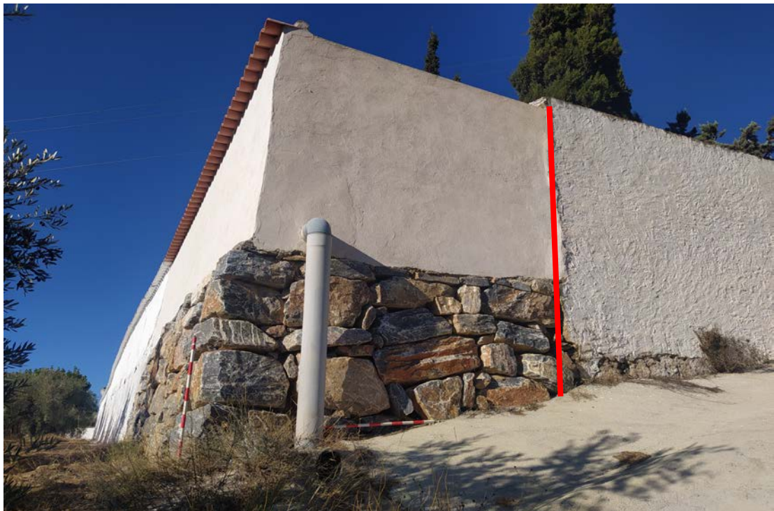
Figura 4.37 – Imagen obtenida por el equipo los primeros días de la intervención (11/2021). Se puede observar el muro de factura reciente, que se apoya en unos grandes cimientos de bastante potencia (unos 2 metros mínimo) formados por hormigón y piedras de gran tamaño. El nivel de circulación actual se situaría a la altura de la cañería de desagüe
