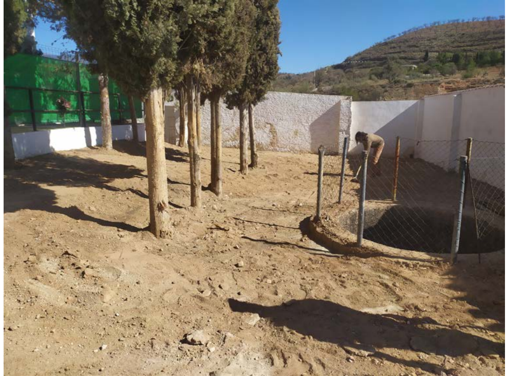
Fig. 4.155 – Repuesto al estado previo del inicio de los trabajos en el área de actuación.
