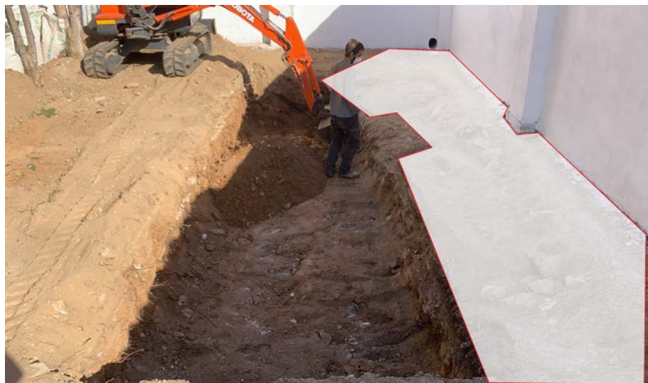
Fig.4.54 -4.55 – 4.56 – 4.57 - Retirada de los primeros estratos; detalle de la zapata de hormigón que se extiende hacia el interior del cementerio, y que funcionaría como cimientos del muro nuevo, lo cual nos impide sondear las zonas más cercanas a la tapia perimetral.
