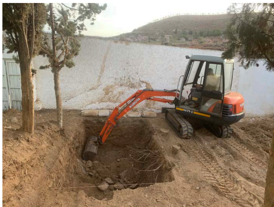
Fig. 4.142 – Trabajos de apertura con maquina retroexcavadora en el sondeo002
