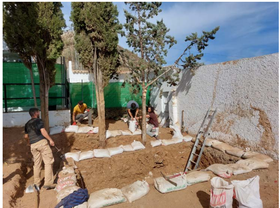
Fig. 4.144 –Proceso de instalación del perímetro de protección de sacos terreros en el sondeo 002
