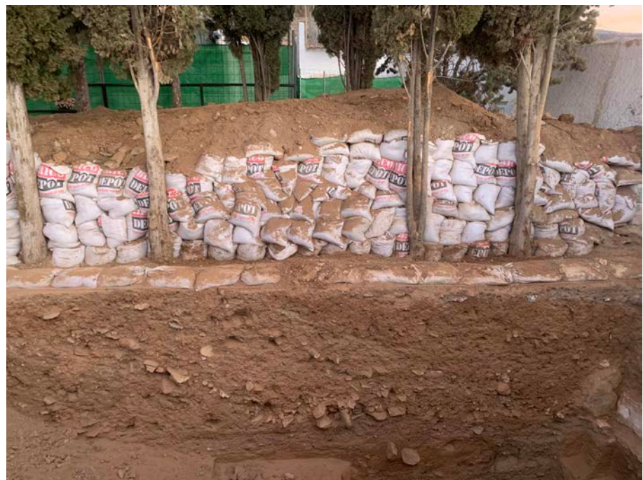
Fig. 4.139 – Terrera y sondeo001 previo a su relleno con máquina retroexcavadora.
