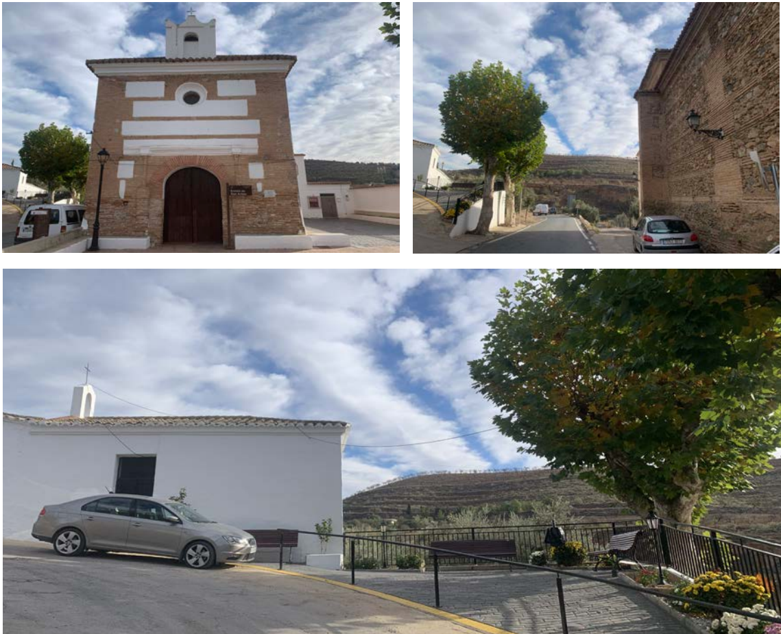
Fig. 4.46 – 4.47 – 4.48 – Tendido eléctrico desde la Ermita de San Antón hasta el espacio cedido por el ayuntamiento en el interior del cementerio
