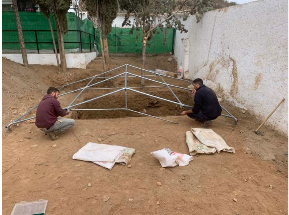
Fig. 4.143 – Montaje de carpa de protección sobre sondeo002
