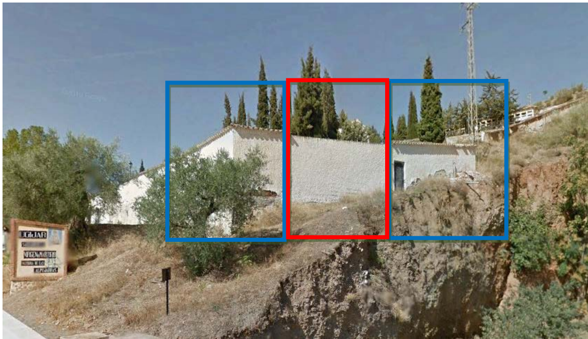
Figura 4.35 – 4.36 – Imagen obtenida por el equipo los primeros días de la intervención (11/2021). Se marcan al menos tres fases distintas de intervención en el muro.
