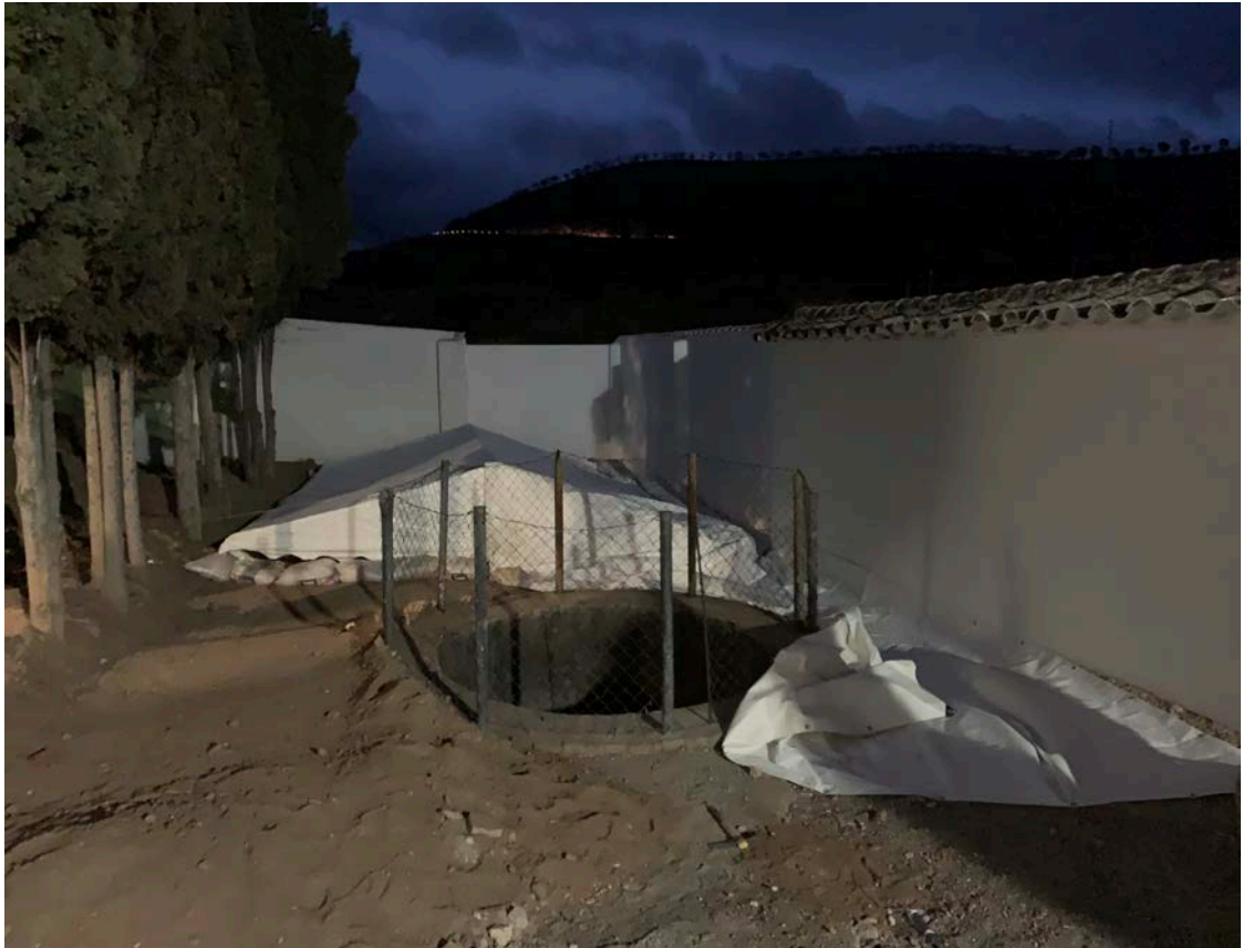
Fig.4.59 - Montaje del perímetro de control de escorrentía y cubierta del sondeo
