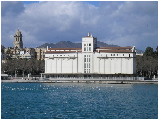
Silo de Puerto. Málaga (Demolido)
