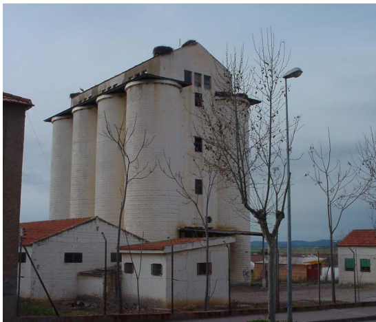
Silo Tipo C. Almodovar del Campo (Ciudad Real)
