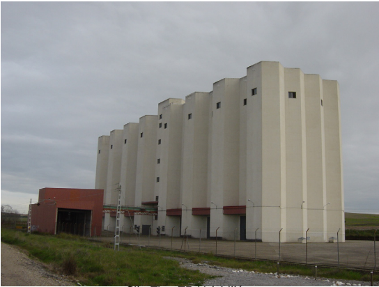
Silo Tipo 1F. Valchillon
