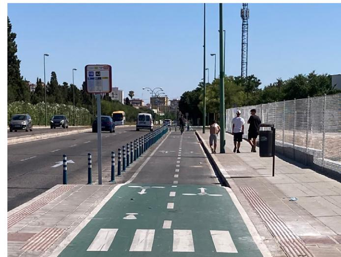
La separación con el tráfico rodado es muy evidente, pero no protegen físicamente en caso de invasión de la vía ciclista por parte del vehículo motorizado.
