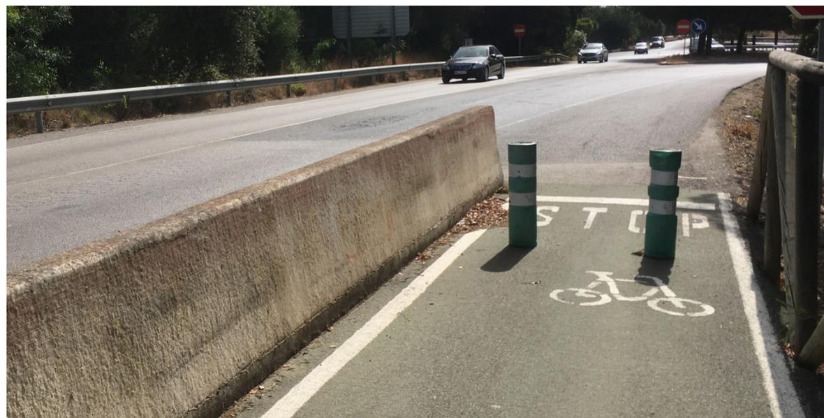
En la instalación de este tipo de separador, que aporta mucha seguridad real y percibida en situaciones de carreteras de intenso tráfico, es preciso atender a que su disposición no suponga una barrera para la fauna y que se solventen adecuadamente los potenciales problemas derivados de la necesidad de la evacuación de aguas de escorrentía.
