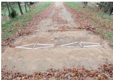
Para instalaciones en tierra bucle ZELT preformado. Los cables están insertados en una funda que permite mantener la forma de rombo.
