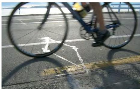
El bucle ZELT clásico consiste en un cable insertado debajo del asfalto en forma de rombo. Instalado a 4 cm de profundidad, es invisible.
