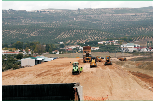
Obras en la Autovía del Olivar. Al fondo, Puente del Obispo.
