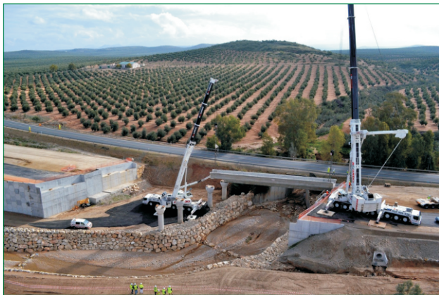
Estructura sobre el Arroyo Vil.
