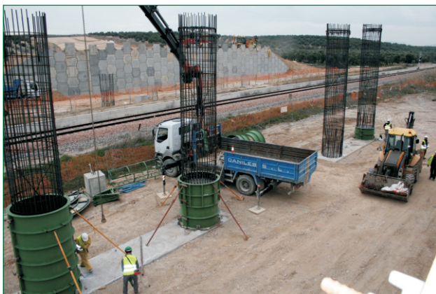
Estructura sobre el ferrocarril.
