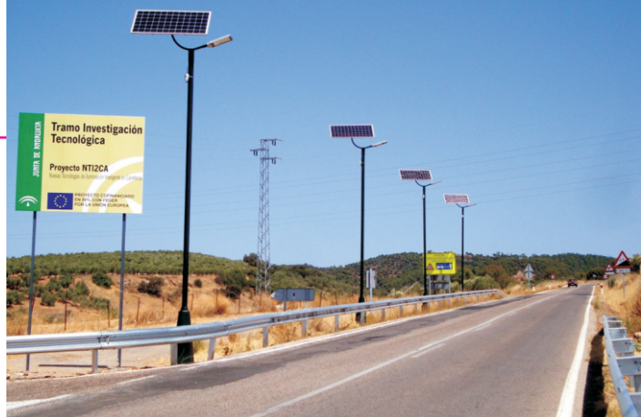
Intersección norte en la A-421 en Villafranca del Río (Córdoba).
