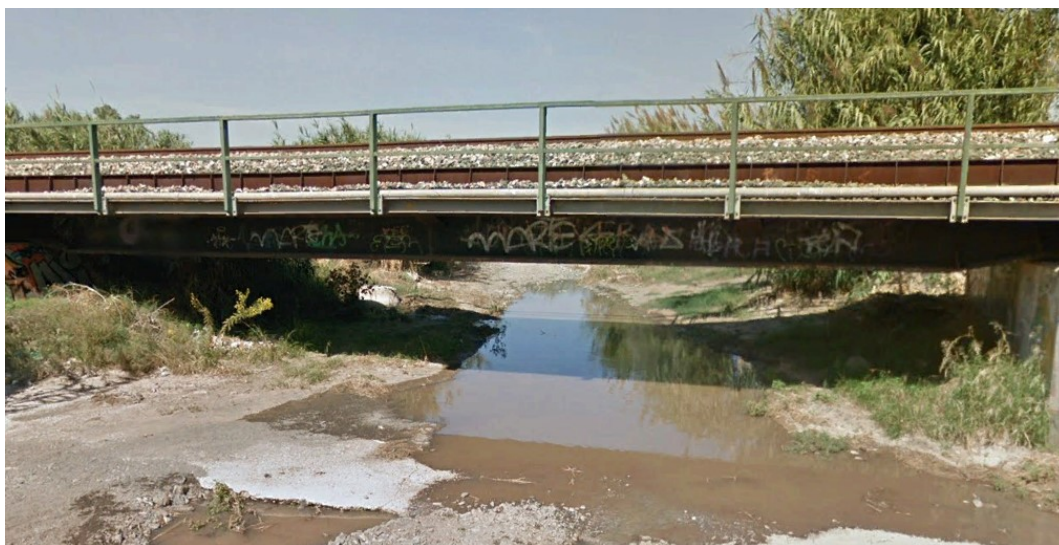
Ilustración 26. Arroyo de Torres a su paso por el noreste de la futura depuradora, bajo la línea de ferrocarril.
