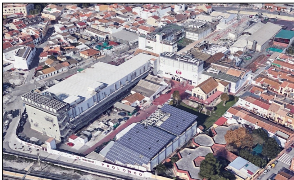
Ilustración 90. Complejo Cárnico FACCSA-Prolongo. Paneles solares en cubierta (2)
