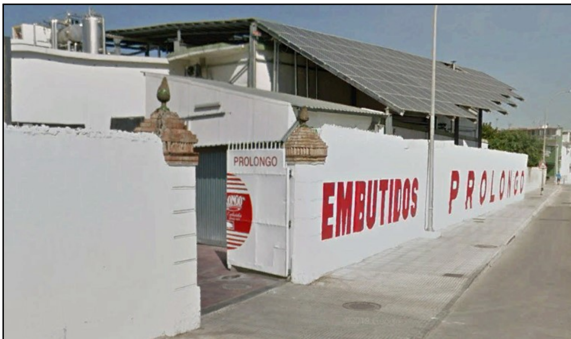
Ilustración 89. Complejo Cárnico FACCSA-Prolongo. Paneles solares en cubierta (1)
