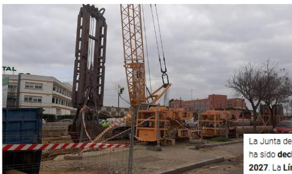
Pantalladora para la construcción del túnel de la Línea 3 Norte del Metro de Sevilla.
