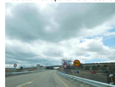
Obras de mejora de la línea ferroviaria llegando a Jaén (N-323A)
