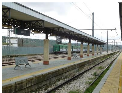
Andújar: Andenes de la Estación de tren
