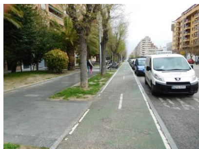
Jaén: Carril bici existente en Av. Andalucía sin zona de resguardo de estacionamiento
