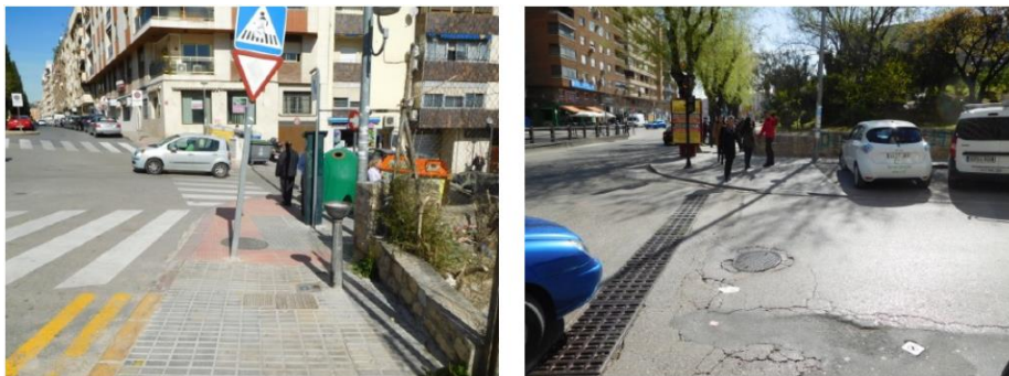
Ilustración 10: Acera poco accesible debido al mobiliario urbano, falta de mantenimiento y de paso peatonal. Fuente: Elaboración propia.
