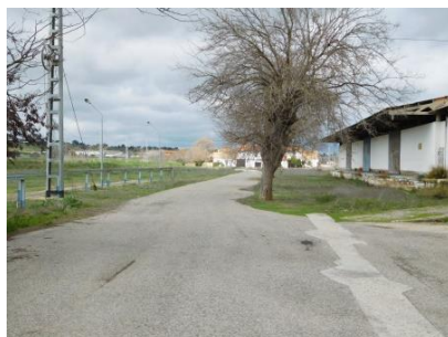
Espelúy: Acceso a la Estación de tren
