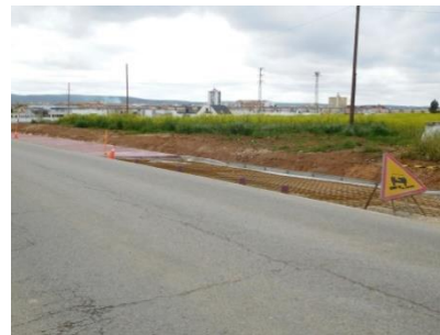
Andújar: Carril bici de Andújar en construcción
