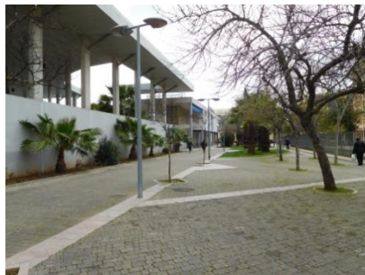
Andújar: Acceso peatonal a la estación de autobuses
