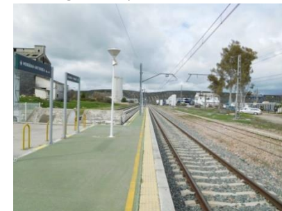
Mengíbar: Apeadero ferroviario
