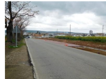
Andújar: Carril bici de Andújar en construcción
