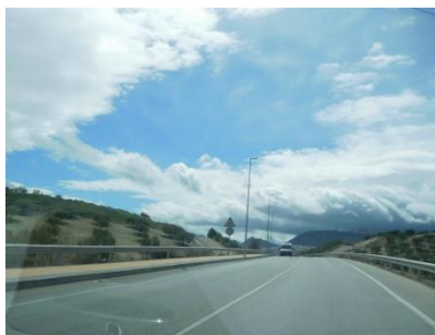
Jaén: Vía de comunicación entre Jaén y el P.E. Nuevo Jaén con acerado
