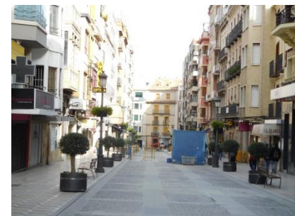
Jaén: Obras de peatonalización de una de las calles principales de acceso al casco histórico de Jaén
