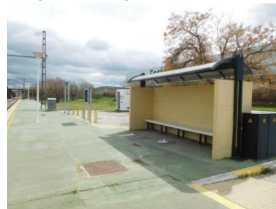
Mengíbar: Apeadero ferroviario
