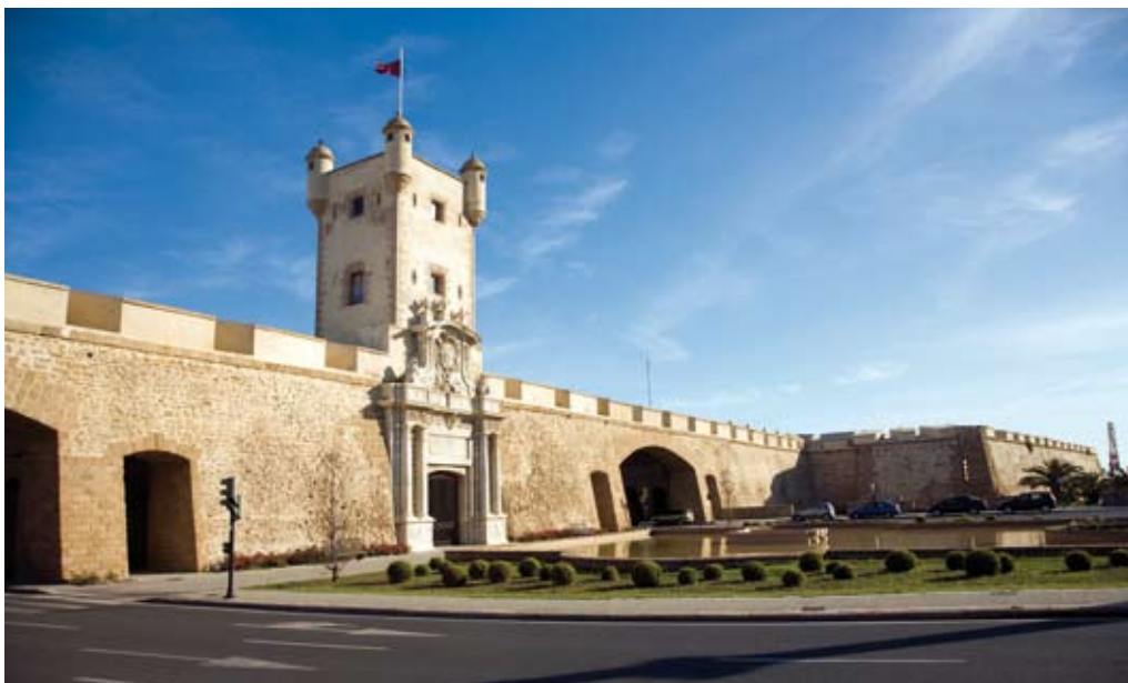
Baluarte de Puerta Tierra, Cádiz.
